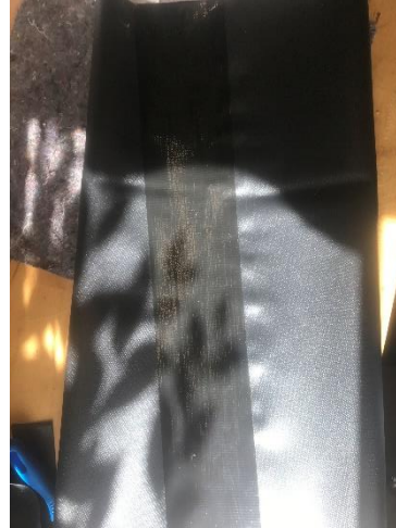
Verklebung der Folie an der Fügestelle
