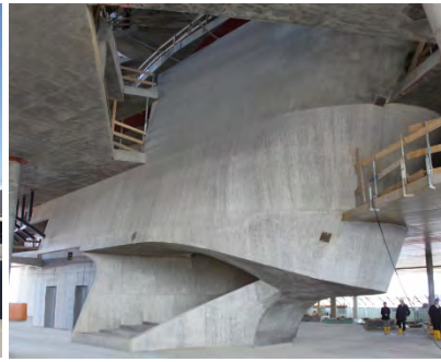
Bild: Elbphilharmonie Hamburg Quelle: www.jdarchitekten.de
