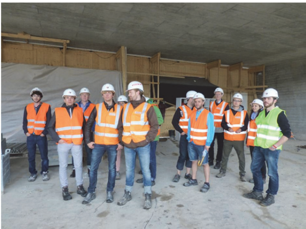
Flughafen Zürich: Bauer Spezialtiefbau, Exkursionsteilnehmer Energiepfähle
