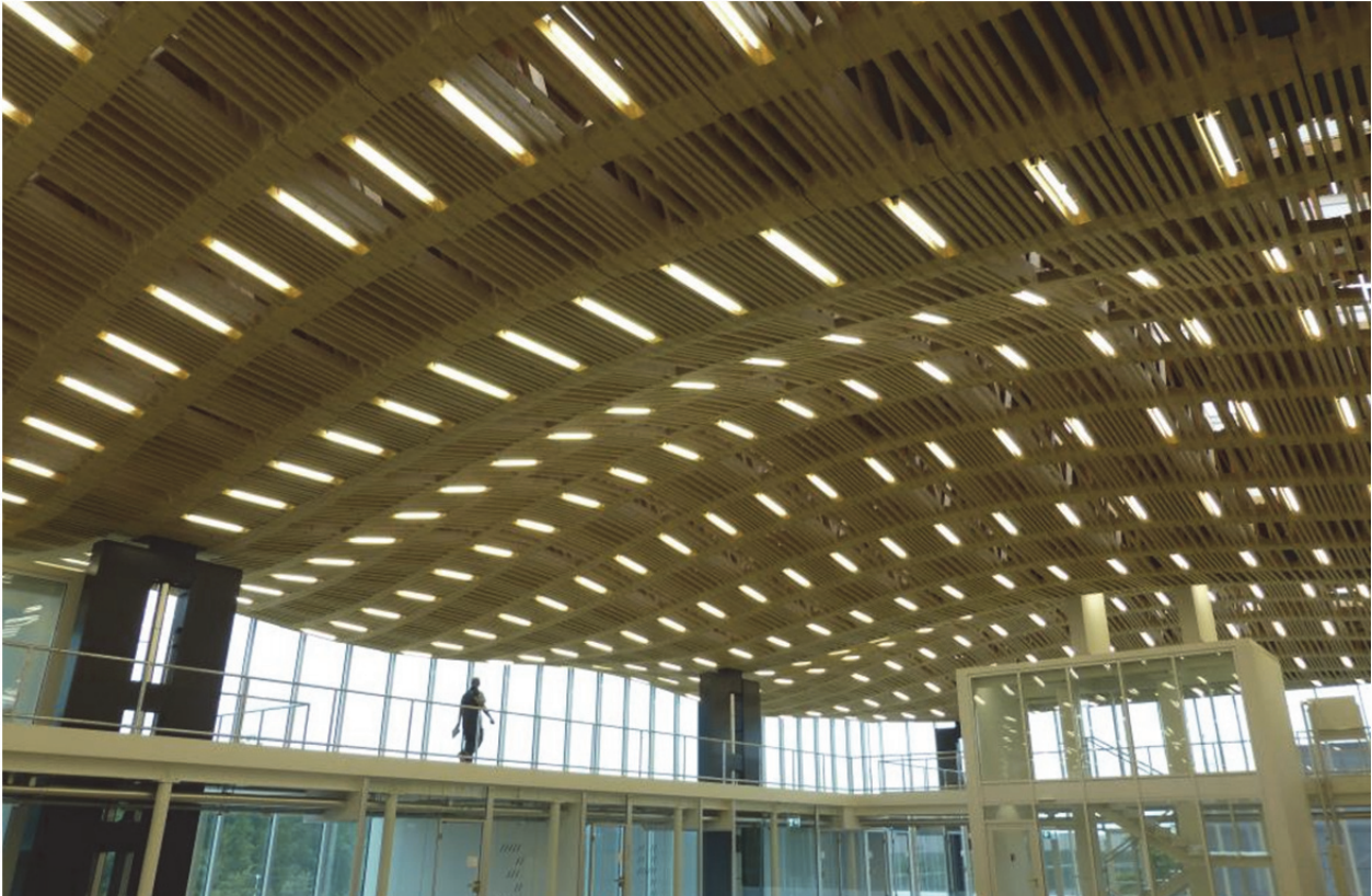
ETH Zürich: Parametrisch entworfenes und digital gefertigtes Dach
