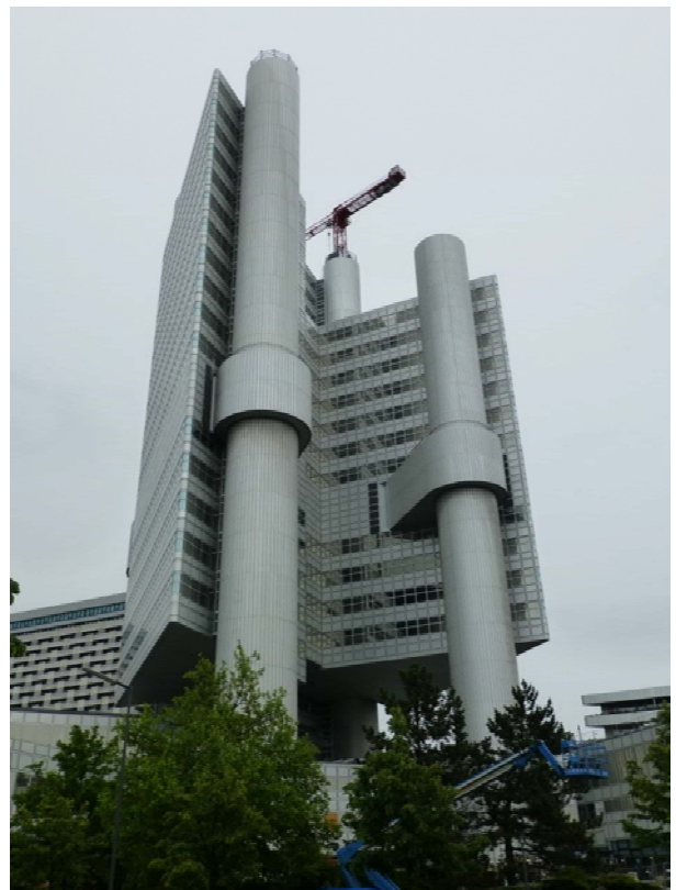
Greenbuilding Sanierung des HVB-Towers in München
