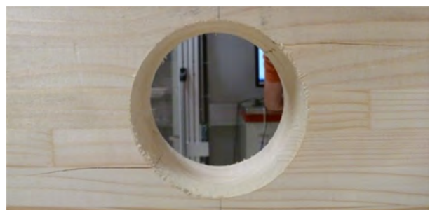
Bild 14: Versagen im Bereich der Aussparung bei Trägern ohne Verstärkungen
