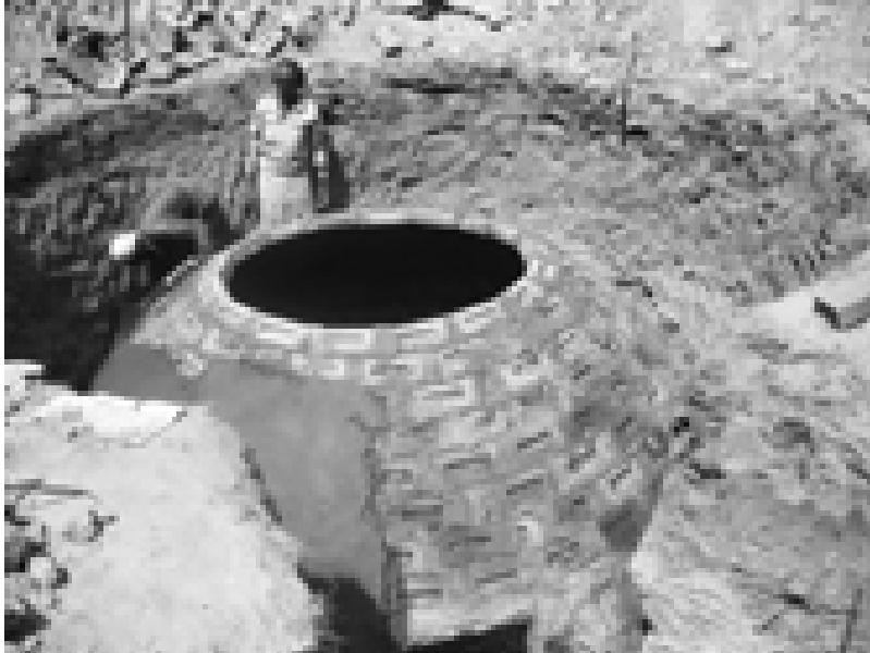
Prototyp einer Biogasanlage, die Küchenabfälle fermentiert, im Bau. Die Anlage entstand im Rahmen einer Masterarbeit
