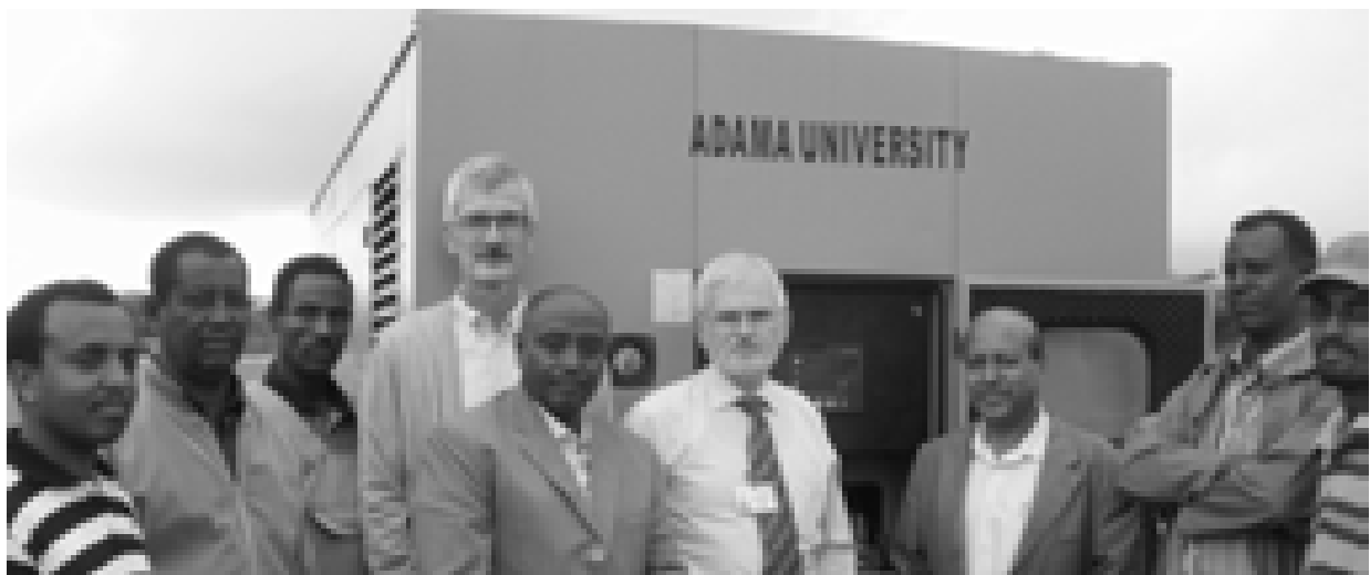
Abnahme eines 680 kVA Notstromgenerators für den Universitäts-Campus
