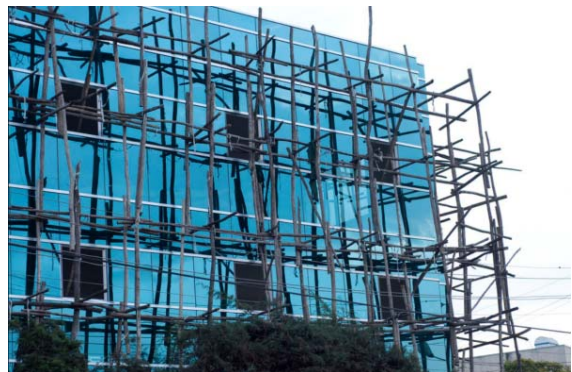
Baustelle in Addis Abeba – beeindruckende Holzgerüste
