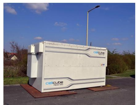
*Redox-Flow Batteriespeicher mit 10 kW und 100 kWh*
