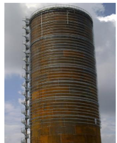
Abbildung 10: Wärmespeicher der N-Ergie in Nürnberg während der Bauphase [2]
