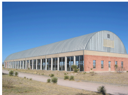
Abb. 163: Nördliche Artilleriehalle, Außenansicht The Chinati Foundation, Marfa, Texas Foto: Ulrike Rehwagen, 2006
