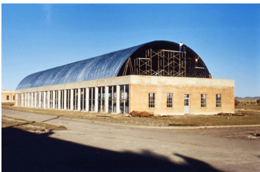
Abb. 224: Südliche Artilleriehalle, Dachbaustelle und Originalflachdach The Chinati Foundation, Marfa, Texas Aus: Stockebrand, Marianne: The Making of Two Works: Installations at the Chinati Foundation, Vortrag am Courtauld Institute, London, am 26. Februar 2004, in: Chinati Newsletter Vol. 9, Oktober 2004, S. 45–61, S. 59.
