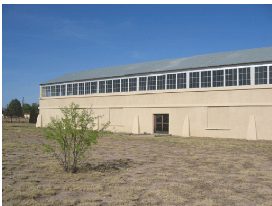
Abb. 168: Arena, Seitenansicht The Chinati Foundation, Marfa, Texas Foto: Ulrike Rehwagen, 2006
