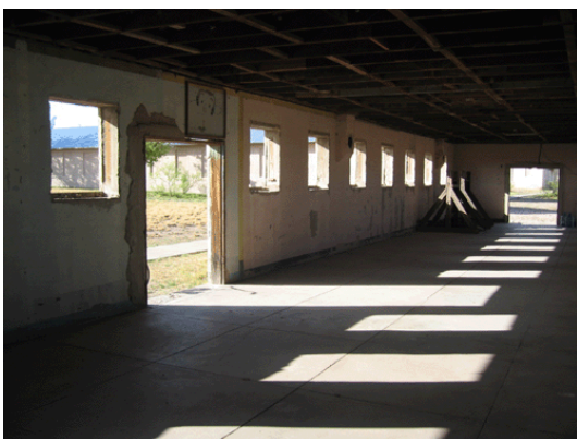
Abb. 186: Ehemaliger Speisesaal mit historischer Wandmalerei von 1940–1950 The Chinati Foundation, Marfa, Texas Foto: Ulrike Rehwagen, 2006
