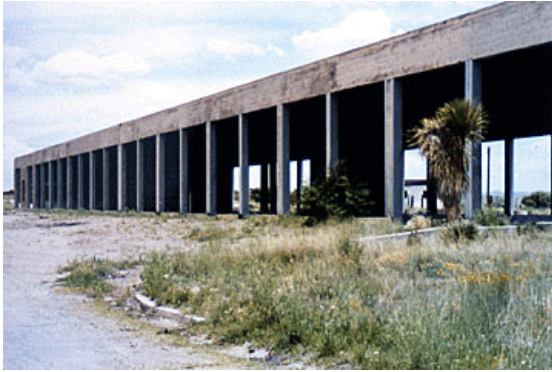
Abb. 220: Artilleriehallen ohne Garagentüren, Umbauphase The Chinati Foundation, Marfa, Texas Aus: Abbildung zur Verfügung gestellt von The Chinati Foundation, Marfa, Texas, durch Herrn Nick Terry. © The Chinati Foundation, Marfa, Texas
