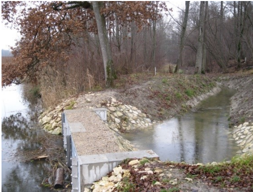
Abb. 4-16: Bauwerke für die Grundwasserabsenkung. Links: Ausleitungsbauwerk bei der „Alten Donau“. Rechts: Einsetzen der Dammbalken durch Mitarbeiter des WWA Ingolstadt in das 1. Absperrbauwerk (Fotos: Peter Fischer, 2011).
