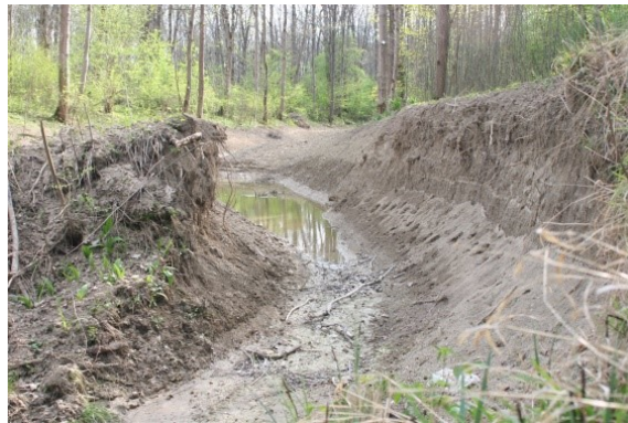
Abb. 4-22: Standort am „Wetterloch“. Links: Blick über das gesamte „Wetterloch“ (entgegen der Fließrichtung) mit bereits erfolgtem Durchstich zur Wiederherstellung der aquatischen Durchgängigkeit (Foto: Peter Fischer, 2010); Rechts: Detailaufnahme der Engstelle (Foto: Peter Fischer, 2010).
