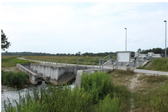
Abb. 4-12: Ausleitungsbauwerk und erster Abschnitt des Ottheinrichbaches. Links: Ausleitungsbauwerk mit Fischpass (Foto: Peter Fischer, 2015). Rechts: Kurze Anbindung zum stark getrübbten Längenmühlbach und „Trogbrücke“. Im Hintergrund der Beckenpass (noch ohne Wasser) und die obere Flutmulde (Foto: Peter Fischer, 2010).
