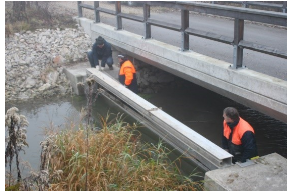
Abb. 4-16: Bauwerke für die Grundwasserabsenkung. Links: Ausleitungsbauwerk bei der „Alten Donau“. Rechts: Einsetzen der Dammbalken durch Mitarbeiter des WWA Ingolstadt in das 1. Absperrbauwerk (Fotos: Peter Fischer, 2011).
