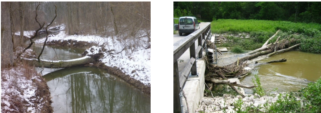
Abb. 6.2-5: Totholzeintrag im OHB. Links: Natürlicher Totholzeintrag ins Fließgewässer durch Sturzbäume (Foto: Aueninstitut 2013) und Verklausung an der „Inselbrücke“ am 1. Absperrbauwerk (Foto: Peter Fischer 2013).
