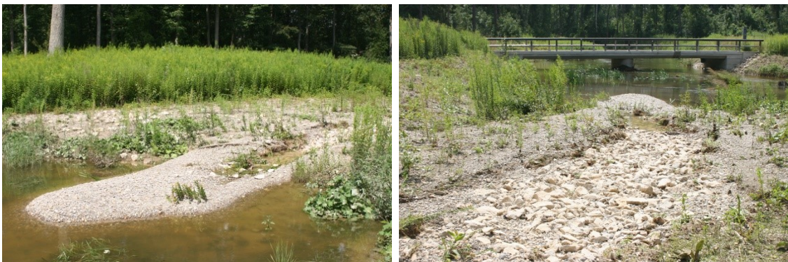
Abb. 4-20: Standort an der „Wegekreuzung“. Links: Sedimentzunge kurz nach der ersten ÖF, rechts mit Blick in Fließrichtung (Fotos: Peter Fischer, 2011).
