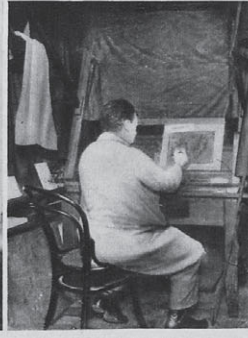
Der Retoucheur arbeitet mit Pinsel und Bleistift das Negative resp. Diapositiv aus, vertieft die Schatten, setzt Lichter auf und hilft überall nach, wo die Kamera versagt hat
