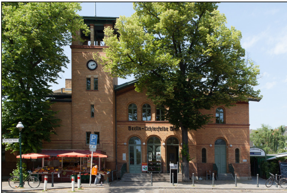
Abbildung 7: Bahnhof Lichterfelde West
