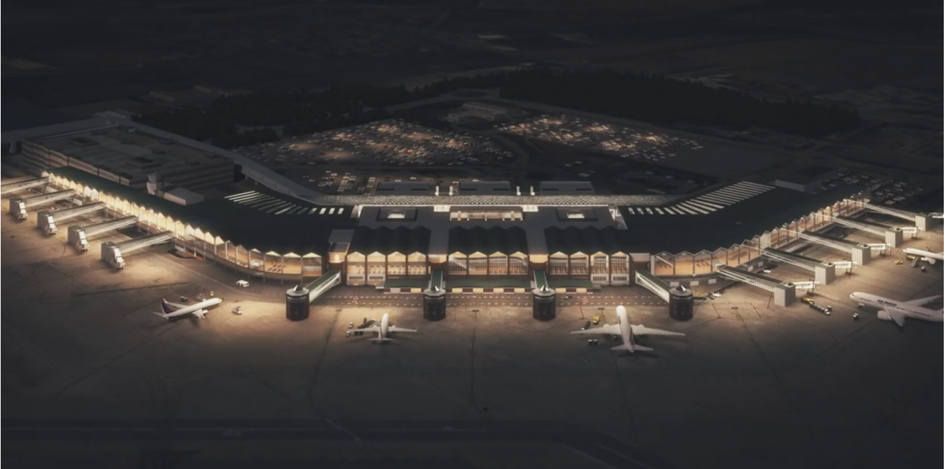
Abb. 2: Projektbeispiel Venice Marco Polo Airport für OneWorks Spa.
