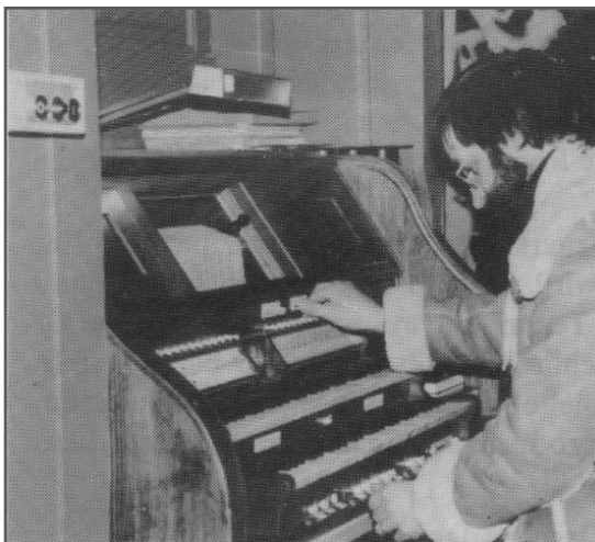
Abb. 3: Ein elektropneumatischer Spieltisch der Firma Walcker, Worms 1913
