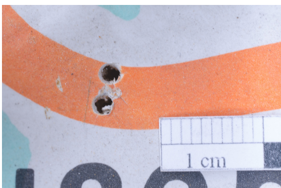
Abb. 76: Segment „K8 Eisenach“, Beispiel für eine fehlende LED, in der Zustandskartierung durch ein graues Diodensymbol gekennzeichnet; vermutlich war hier keine LED vorgesehen und die Bohrungen wurde falsch gesetzt, da der Kabelkanal in einer anderen Richtung verläuft
