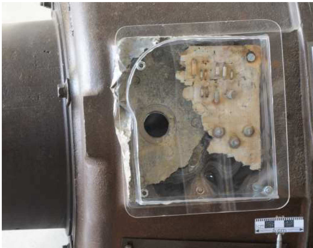
Abb.43: Ergänzung der unteren Generatorsteuerung mit Leiterplattenfragment
