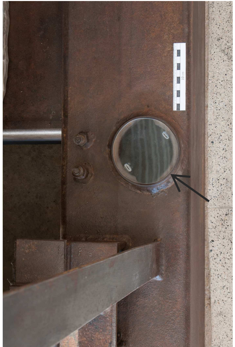
Abb.48: ergänzter Tankdeckel. (Foto Jaßmann)
