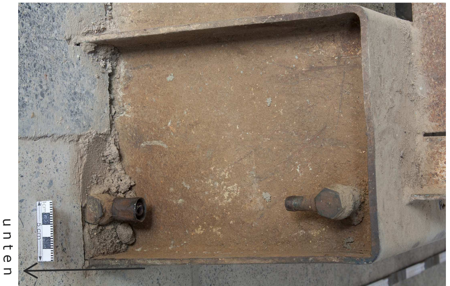
Abb. 10 Anschlüsse der nicht mehr vorhandenen Füllstandanzeige, Westseite. (Foto Klein 2015)
