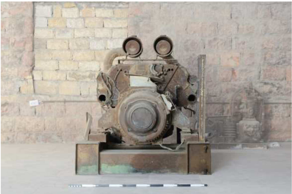
Abb. 3: Dieselgenerator, Westseite, Vorzustand
