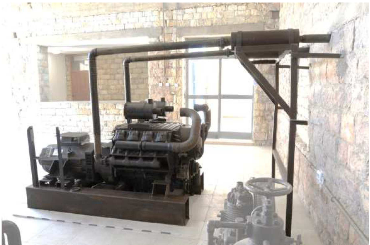
Abb. 4: Dieselgenerator, Südseite, Nachzustand
