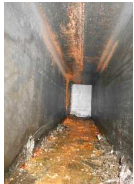
Abb. 11: Tank, innen, Nordseite
