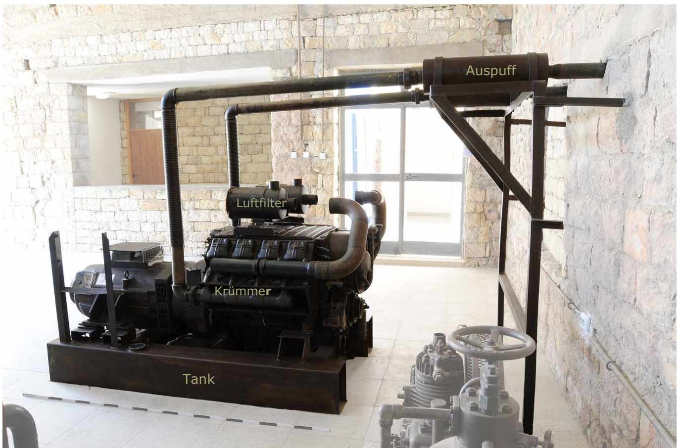
04 Dieselgenerator, Nordseite, nach der Konservierung. (Foto Jaßmann 2015)
