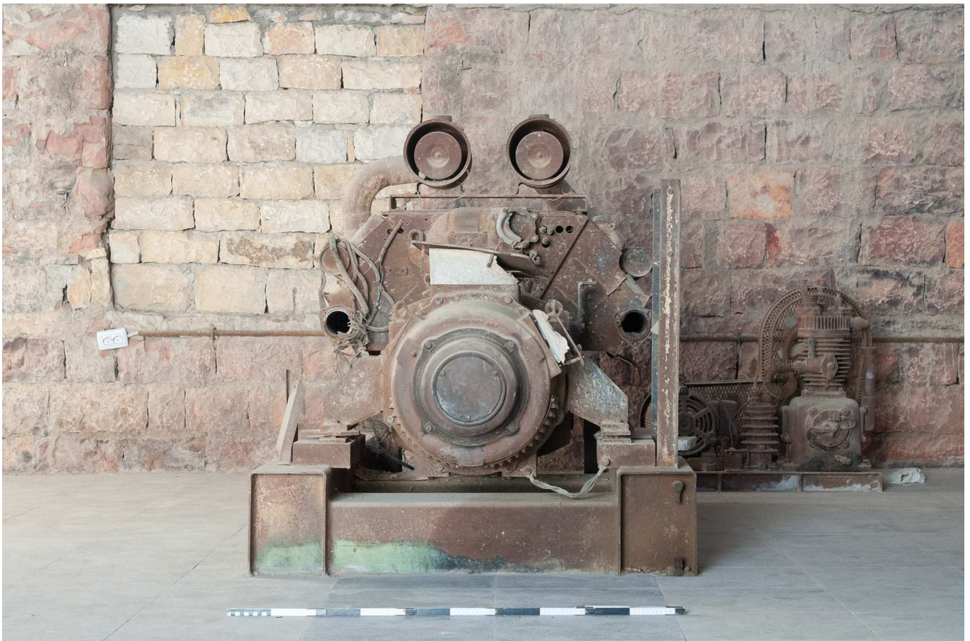
03 Dieselgenerator, Westseite, vor der Restaurierung; rechts hinten an der Wand: Kompressor für die Befüllung der Druckluftflasche des großen Motors. (Foto Jaßmann 2015)
