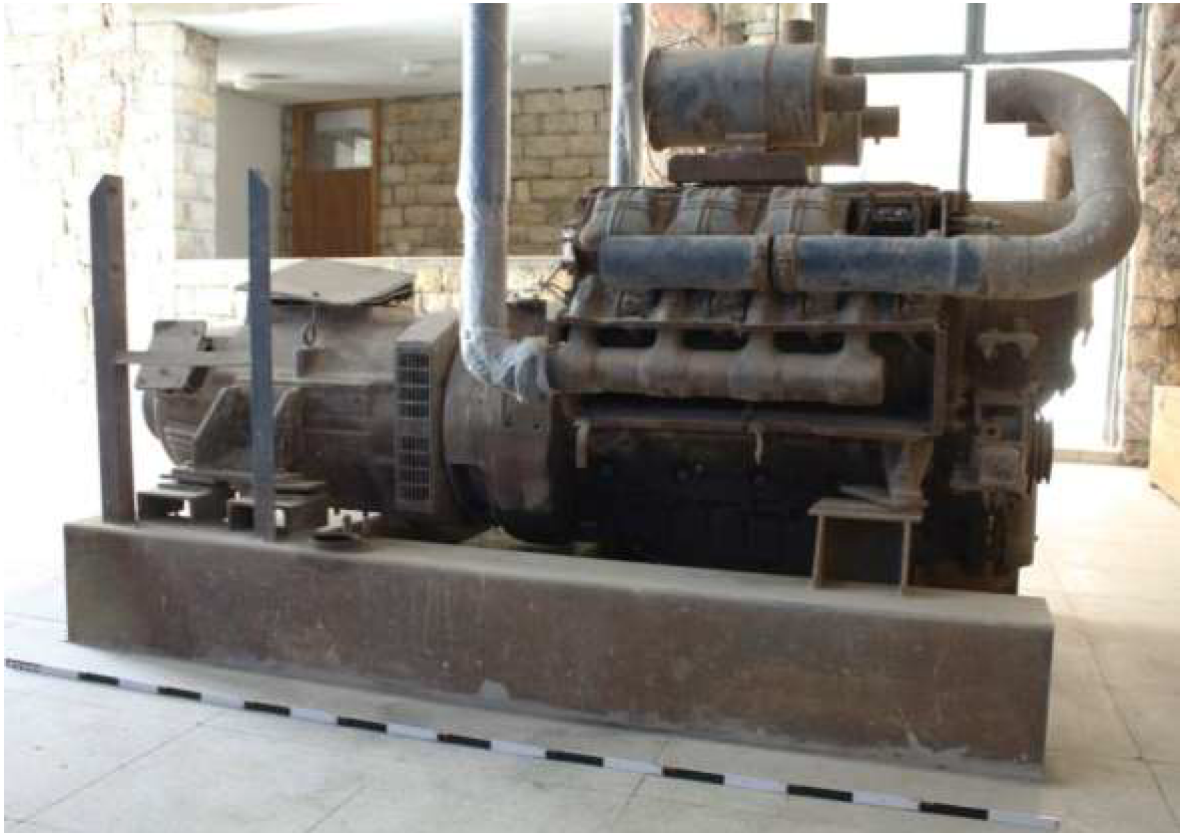
Abb. 17: Gesamtansicht Südseite, Vorzustand
