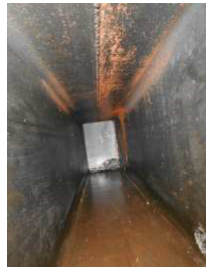
Abb. 39: Tank, innen, Nordseite, Nachzustand
