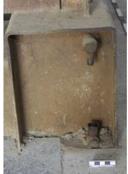
Abb. 10: fehlende Füllstandanzeige, Westseite
