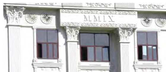
18 | Südliche Fassade des Außenministeriums
