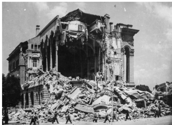
5 | Vom Erdbeben zerstörtes Offiziershaus
