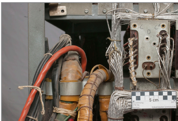
Abb. 539: Detail Spielseite Elektronikgestell, Kabelbaum und Tastsystem Oberwerk „C C“
