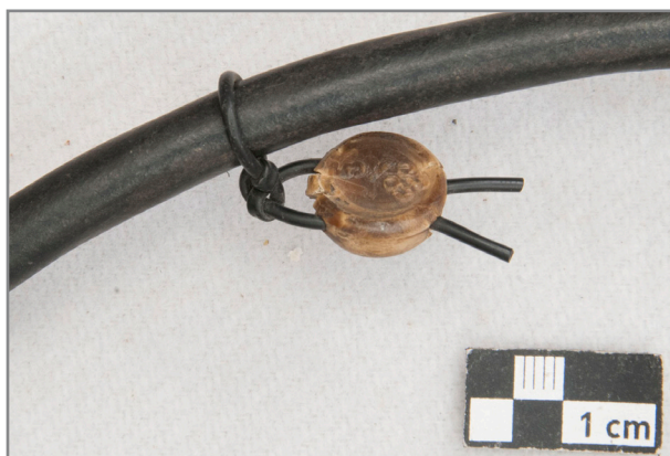
Abb. 600: Detail Netzkabel, Plombe „5“, Rest nicht entzifferbar
