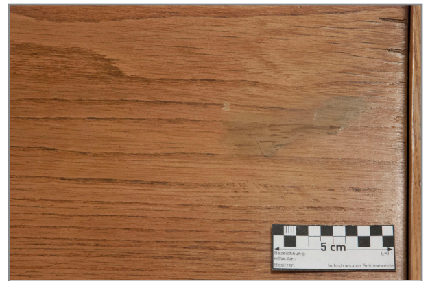
Abb. 202: Detail Deckel Wölbung, Kittung an der rechten Kante des Deckels
