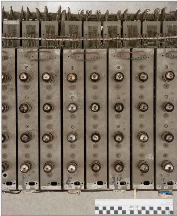
Abb. 326: Detail Oberseite Elektronikgestell, vor der Trockenreinigung, je zwei Chassis der Frequenzteilerketten der Grundtöne „F“, „E“ und „Dis“ sowie eins des Grundtons „D“, silberne Farbaufträge nahe der vorderen und rückwärtigen Kanten der Frequenzteilerchassis
