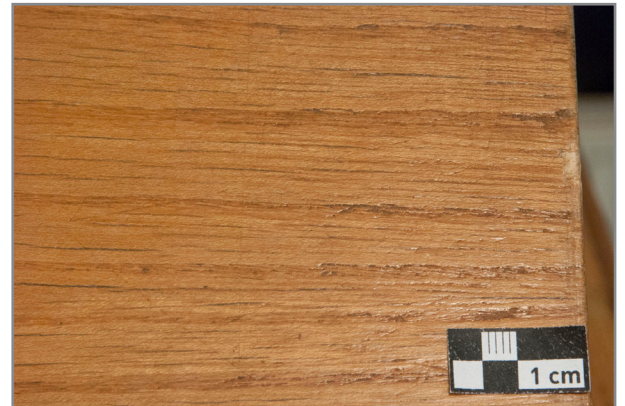
Abb. 208: Detail Deckel Wölbung Innenseite, Fehlstelle im Holz des Deckels an der rechten Kante
