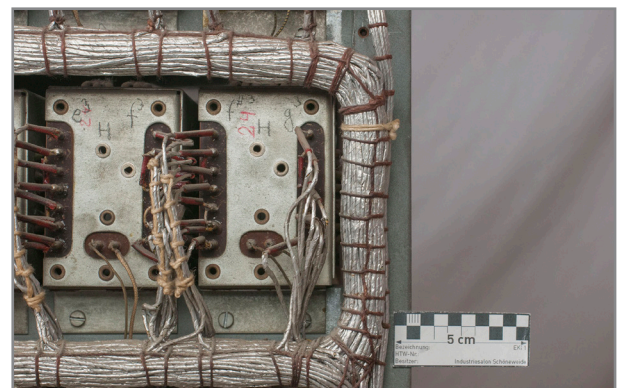
Abb. 564: Detail Spielseite Elektronikgestell, Tastsysteme Hauptwerk „e 3 f 3 “ und „f #3 g 3 “, sehr eingedrückte Kabelbäume erkennbar
