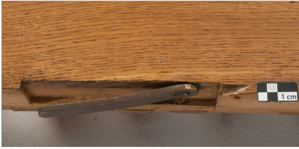
Abb. 142: Detail Bankseite Pedal, Verriegelungsmechanismus für die Bank, Holzausbruch
