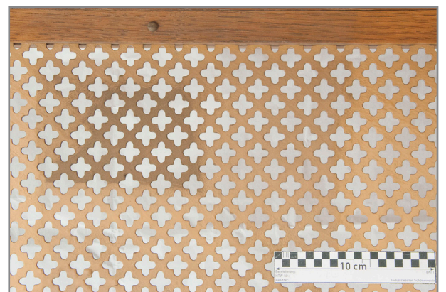
Abb. 283: Detail Innenraum Gitter, links Vorzustand, mitig Reinigung trocken, rechts feuchter Mikroschwamm
