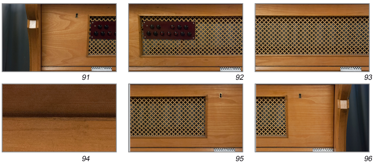
Abb. 91-96: Ansicht des Gitters von außen
