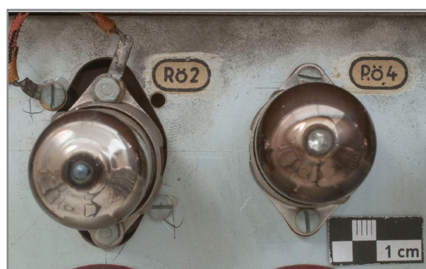
Abb. 312: Detail Vorverstärker Hauptwerk, Markierungen mit Bleistift „+“
