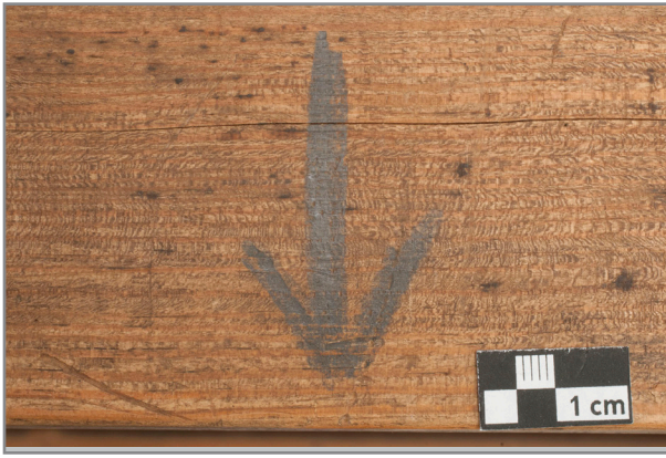
Abb. 229: Detail rückwärtige Abschlussleiste über Vorverstärkern, Bezeichnung der Mitte mit Bleistift „->“
