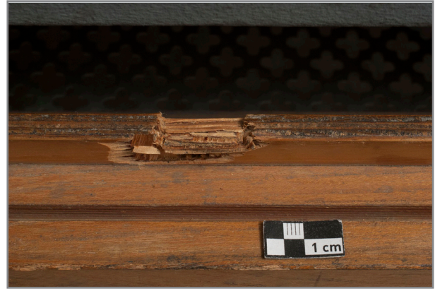
Abb. 250: Detail Rückseite, Ausbrüche im Holz unten in der Mitte des Rahmens
