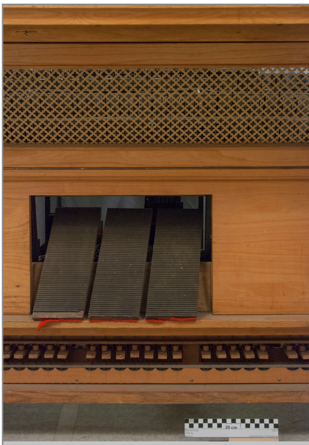
Abb. 81 & 82: Übersicht Fußraum der Orgel mit den drei Teilbereichen (vonu) Gitterelement, Schwellerwand und Pedalmechanik, Mitte rechts und rechts
