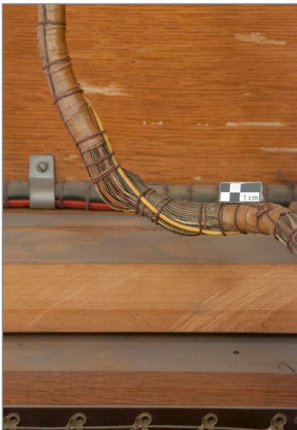
Abb. 293: Detail Innenseite, Kabelbaum der Manuale und Registerwippen, Fehlstellen des umhüllenden Textilkompositmaterials, darunter erkennbar die vielfarbigen Einzelkabel
