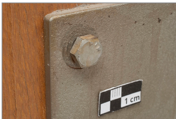
Abb. 181: Detail der rechten Außenseite, äußere Befestigung der Verriegelung des Metallgestells im Innenraum
