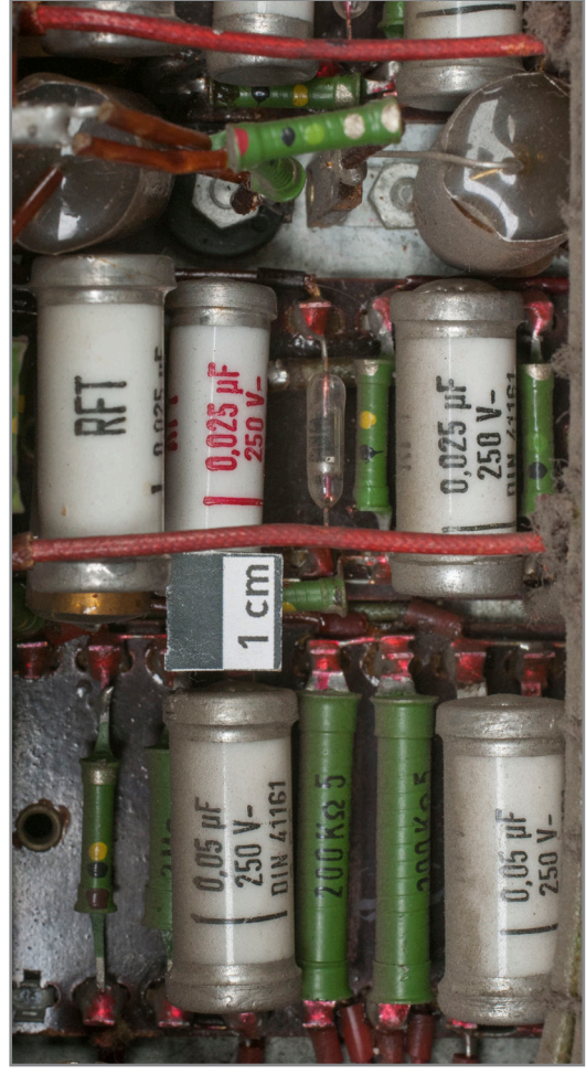
Abb. 466: Detailsicht linke Seite des Elektronikgestells, obere Ebene Tastsysteme, Einblick in ein Tastsystemchassis mit Porzelenkondensatoren, Widerständen, Verkabelung, Diode
