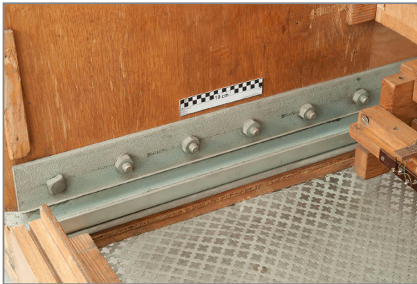
Abb. 279: Detail Innenraum rechtes Seitenteil, Metallschiene für die Rollfüße des Elektronikgestells
