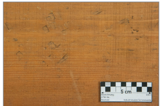
Abb. 170: Innenraum der Bank, Boden, dunkel verfärbte Druckspuren
