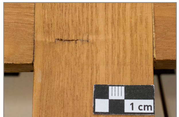
Abb. 10: Detail Notenhalter Rückseite: Aufwölbung und Riss im Holz in mittlerer Längsstrebe auf Höhe der mittleren Querstrebe; Reste eines ausgetretenen Klebstoffs / Überzugs
