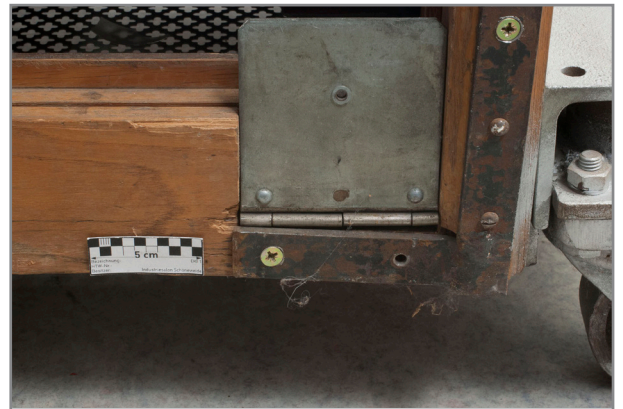
Abb. 254: Detail Rückseite, rechts unten, hochgeklappte Metallrampe zum Ausfahren des Elektronikgestells, rechts daneben und darunter auf dem Holz ein Metallwinkel, befestigt mit zwei korrodierten und zwei vermessingten Schrauben
