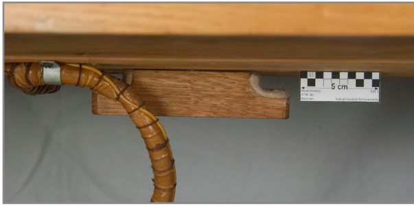
Abb. 284: Detail Innenraum Unterseite Manualkasten, drehbare Aufhängung links für Kabel der Manuale und Registerwippen (links im Bild)
