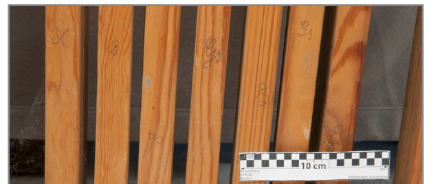
Abb. 140: Detail Unterseite Pedaltasten, Bleistiftbezeichnungen der Tonhöhen
