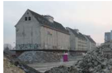
Abb. 11: Speicherkomplex Ansicht Richtung Süden. 2019.
