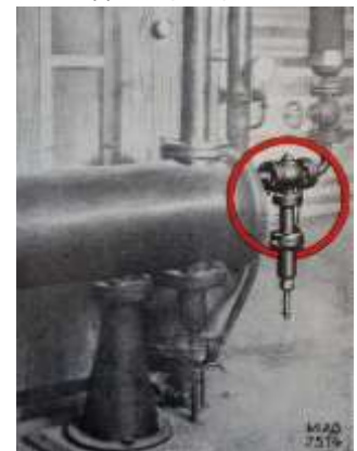
Abb. 121: Gegenstromapparat mit automatischer Temperaturregulierung.
