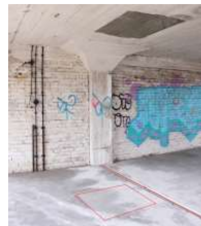
Abb. 71: Zugesetzte Öffnungen, 2. OG.
