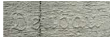
Abb. 6: Gespiegeltes Bild eines Abdrucks in der Decke von Speicher 3, 3. OG.
