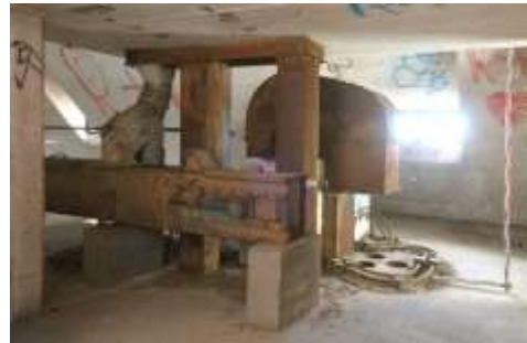
Abb. 52: Spannstation des TKF als Verteilsförderer im 6. OG, Speicher 2. Von oben die Beschickung vom Becherwerk in den TKF.
