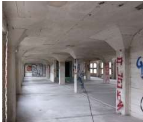
Abb. 4: Nördlicher Innenraum des Speicher 2, 3. OG. mit Pilzkopfstützen. Lastenaufzug mittig im Hintergrund. 2019.
