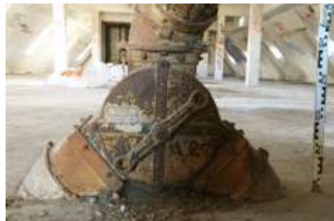
Abb. 62: Weiche zwischen Annahmesilo 1 und 2. 5. OG, Speicher 2.
