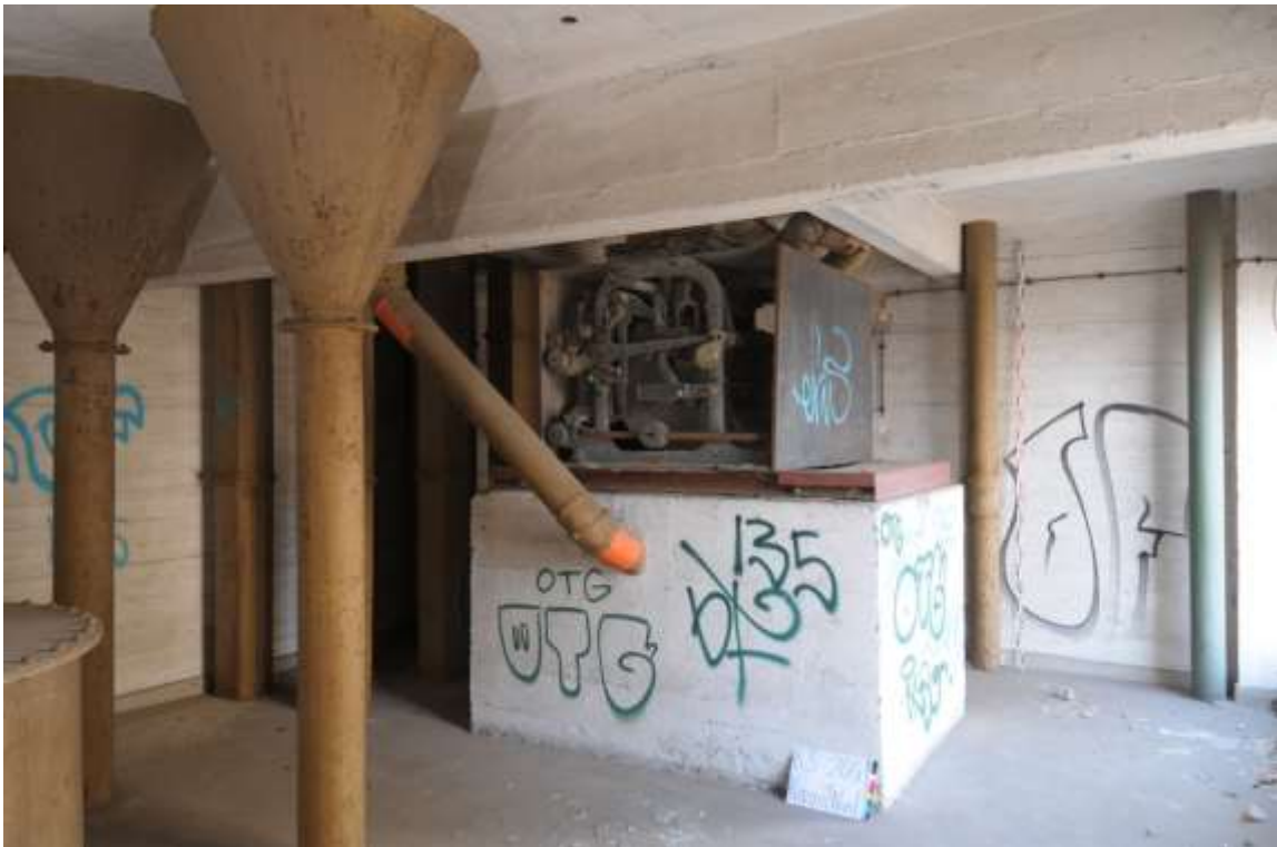
Abb. 74: Übersicht 2. OG, Speicher 2. Der Beton-„Sockel“ umbaut den Ablauftrichter der Waage.
