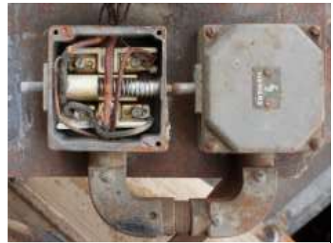
Abb. 155: Detail Wählerschalter mit textilumwickelten Kabeln.
