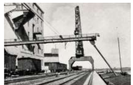
Abb. 16: Trogkettenförderer zur Schiffsbeladung. Um 1935.
