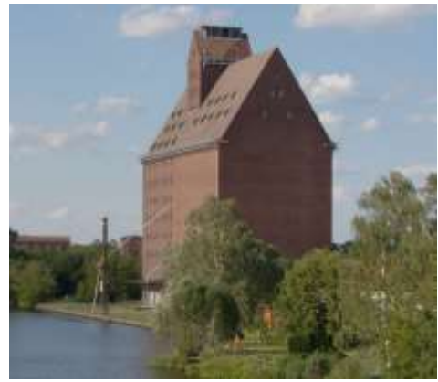
Abb. 175: Ehem. Reichsgetreidespeicher (Typenbau) in Eisenhüttenstadt ca. 2005.
