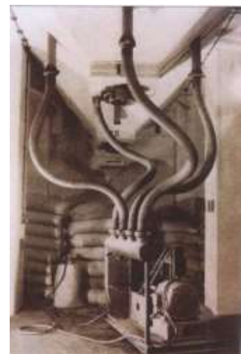
Abb. 139: Ähnlicher Lüfter beim Belüften eines Silos um 1940.
