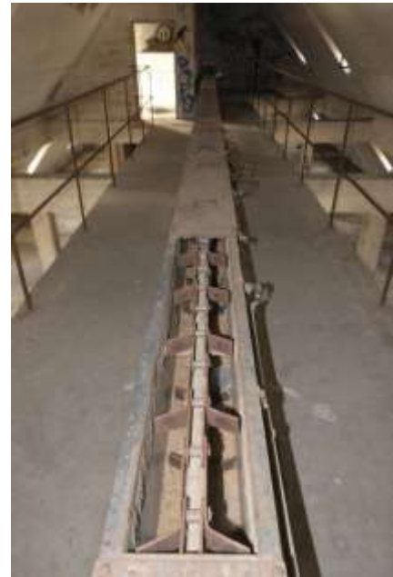
Abb. 50: TKF 6. OG, Speicher 2. Die Abbildung zeigt etwas mehr als ein Drittel seiner Gesamtlänge von ca. 60 m.
