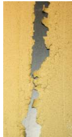
Abb. 164: Abblätternde ockerfarbene Beschichtung auf schwarzglänzender Erstbeschichtung. Doppel-Becherwerk Nr. 3.5.
