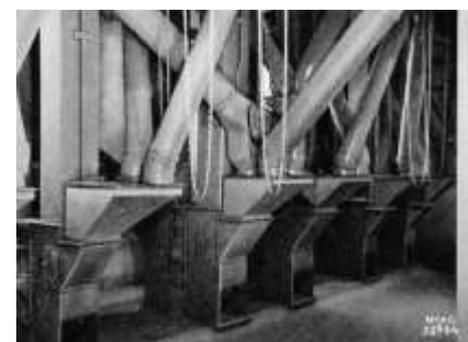
Abb. 39: Becherwerksfüße mit Einlaufnasen um 1935.
