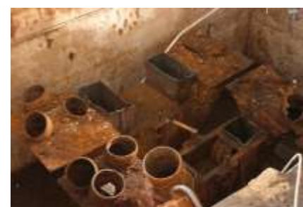
Abb. 40: Zwei von drei Becherwerksfüßen in Speicher 2 während der Demontage. Die Schlote sind schon entfernt.
