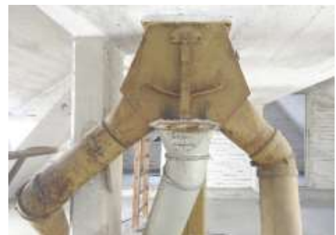
Abb. 64: Angepasste Rohrführung und handschriftliche Richtungsangaben.
