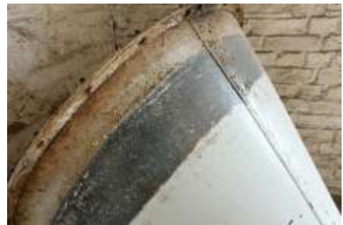
Abb. 166: Demontierter Teil des Zyklons Nr. 12.2. Dunkler Ring ohne hellgraue oder ockerfarbene Beschichtung markiert den Bereich der Betondecke während der Nutzungszeit.
