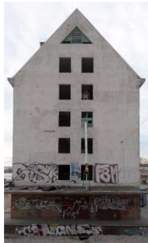
Abb. 5: Nordgiebel Speicher 1 mit Fallrohr zum Beladen von Lkw. 2019.
