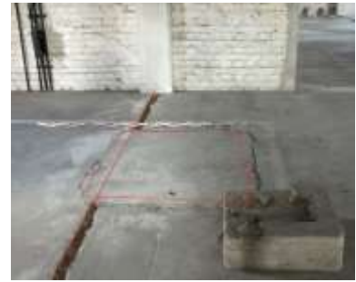
Abb. 69: Zugesetzte Bodenöffnung mit Antriebssockel, 5. OG.
