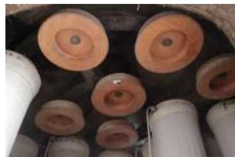
Abb. 108: Aufhängung der Textilschläuche an beweglichen Holztellern aus Buche.
