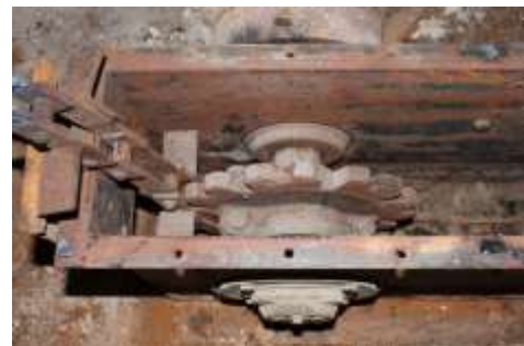
Abb. 53: Kettenstern der Antriebsstation.
