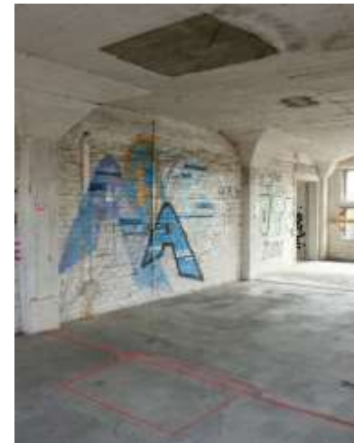
Abb. 70: Zugesetzte Öffnungen, 3. OG.
