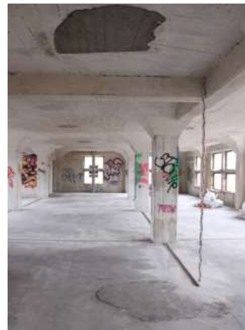
Abb. 65: Zugesetzte Boden- / Deckenöffnungen für eine Sackrutsche.
