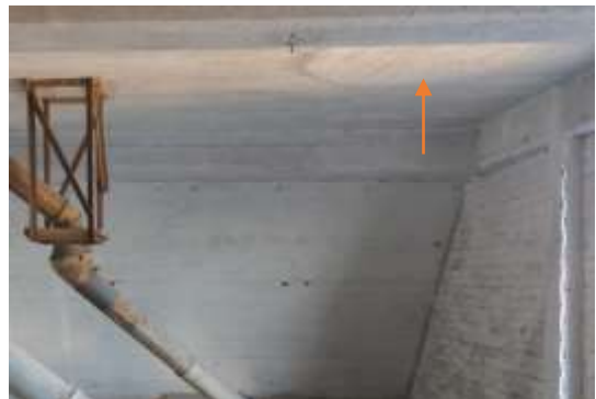
Abb. 7: Nachträglich zubetonierte Aussparung in der Decke (Speicher 1, 5.OG). An dieser Stelle ist in den Vergleichsspeichern ein Staubsammler (Zyklon) verbaut.
