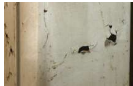
Abb. 38: Becherwerksschlot Speicher 3. Hellgraue Sichtbeschichtung löst sich folienartig.
