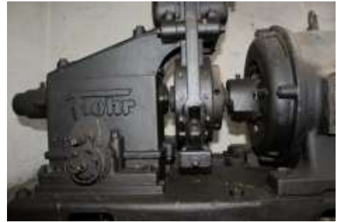
Abb. 8: Detail des Aufzugesantriebs der Firma Flohr. 2019.
