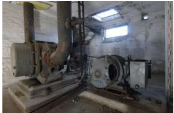
Abb. 17: Drehkolbengebläse (links) und Schleifringmotor.
