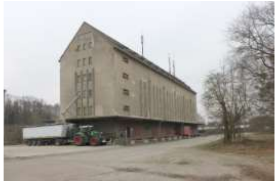
Abb. 184: Silospeicher des ehem. HVA Döberitz bei der Abgabe von Futtermittel.
