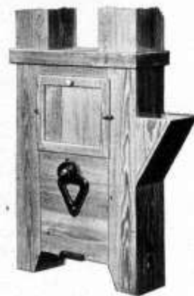
Abb. 42: Becherwerk mit Holzgehäuse um 1935.
