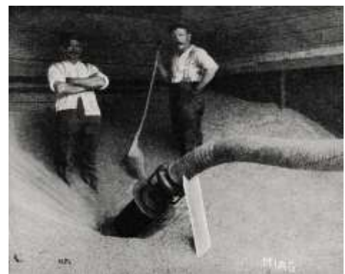
Abb. 19: Arbeiter bei der pneumatischen Schiffsentladung um 1930.
