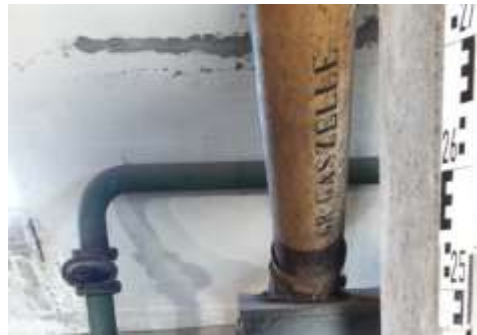
Abb. 61: „Gr. Gaszelle“, 5. OG, Speicher 2.
