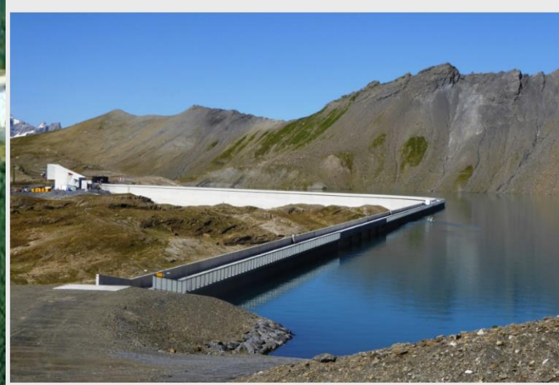
Der hochgestaute Muttssee im Kanton Glarus ist Teil des stärksten Schweizer Pumpspeicherwerks © Hp. Guggenbühl
