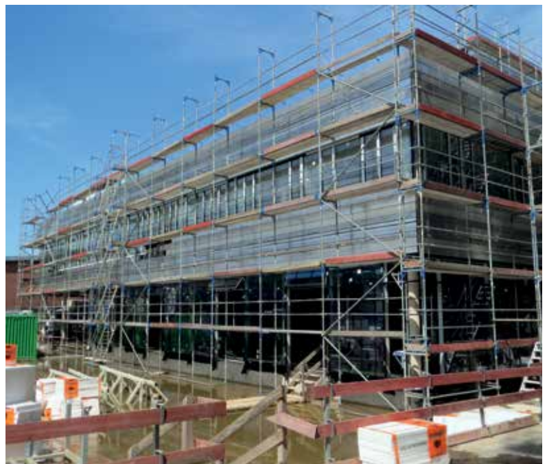
Gebäude 2: Fassade fast komplett
