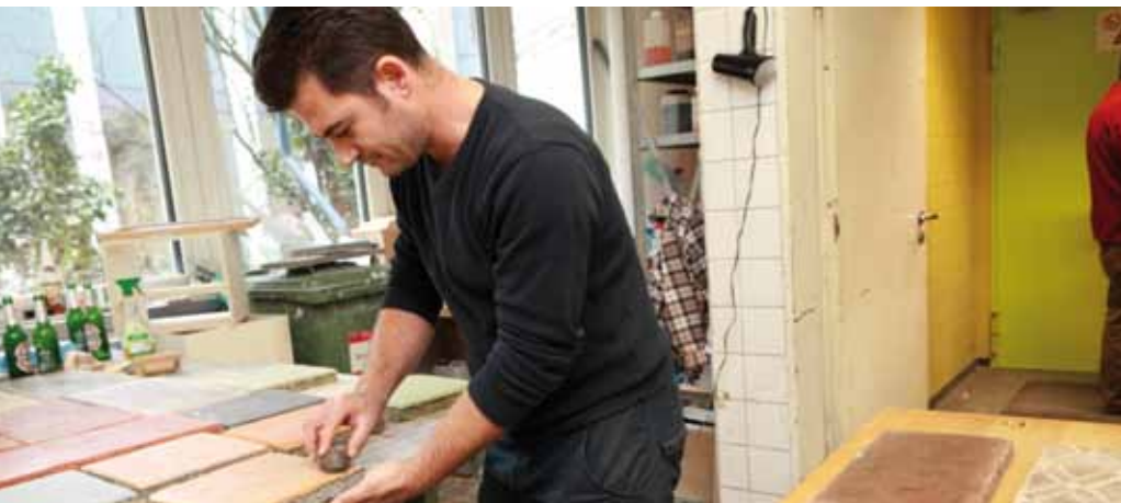
Aus dem Kalkputz Tadelakt lassen sich mit Farbpulvern vielfältige Farbtöne erzeugen. Fotos (3): Jörg Reich
