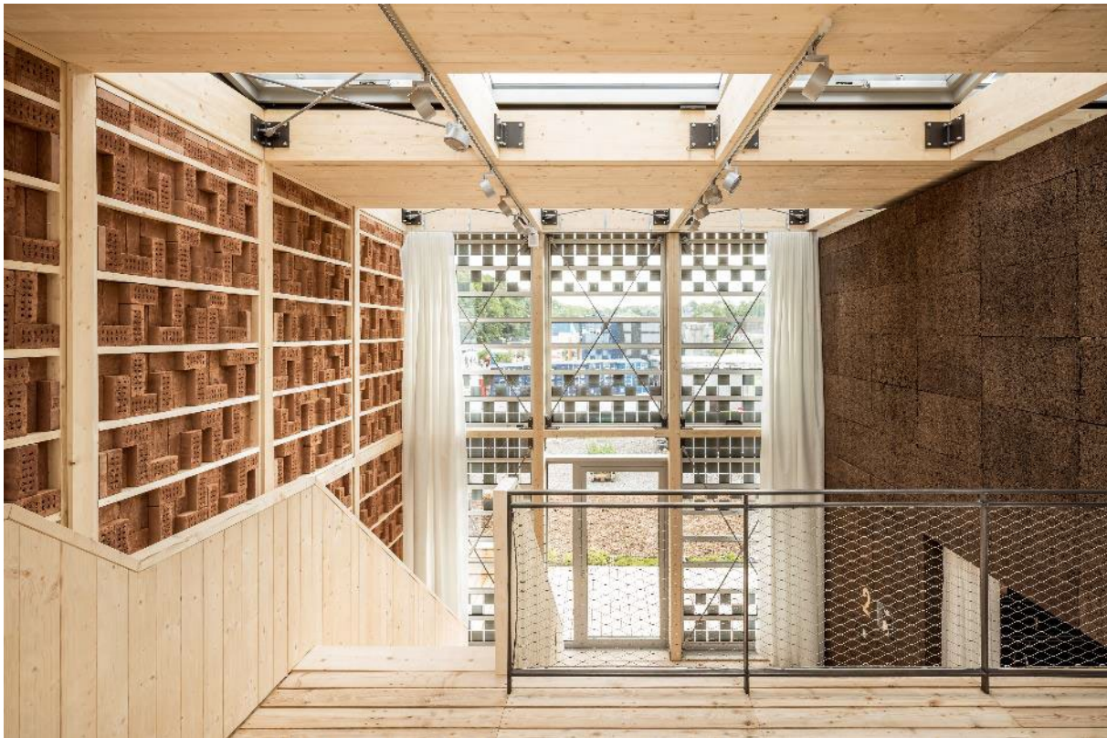
Abbildung 15: Blick von der inneren Terrasse auf dem EG-Wohnmodul in den Gemeinschaftsraum inkl. Lehmsteinen an der Nordwand und Korkbekleidung der OG-Wohnmoduls, Foto Marvin Hillebrand
