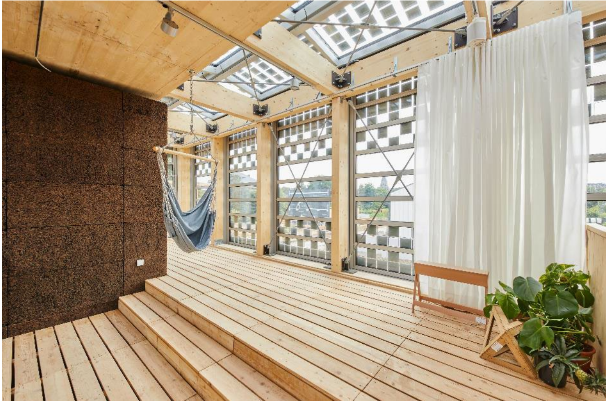
Abbildung 21: Blick auf die Westfassade mit PV-Zellen in geöffneten Fensterlamellen und die innere Terrasse im OG-Bereich, Foto Marvin Hillebrand
