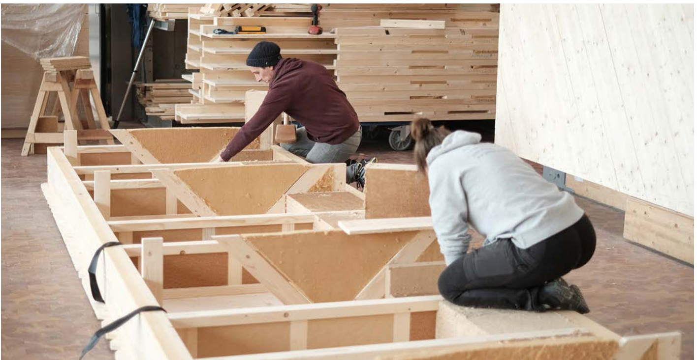
Abb. 306: Arbeitsintensive Vorfertigung der Wandelemente mit thermisch getrennten Leiterträgern
