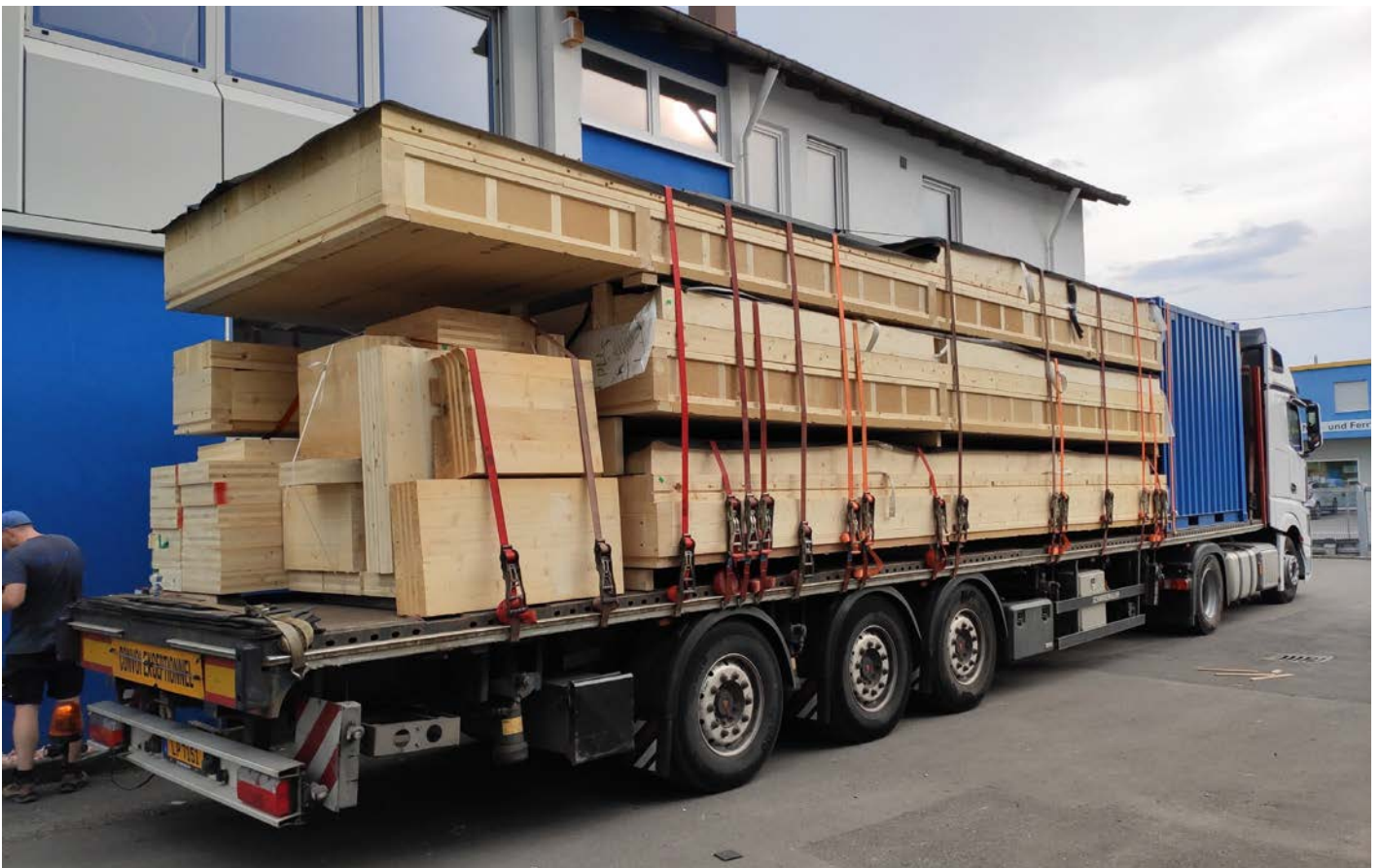
Abb. 308: Beladener LKW mit vorgefertigten Bodenelementen und Montagezubehör
