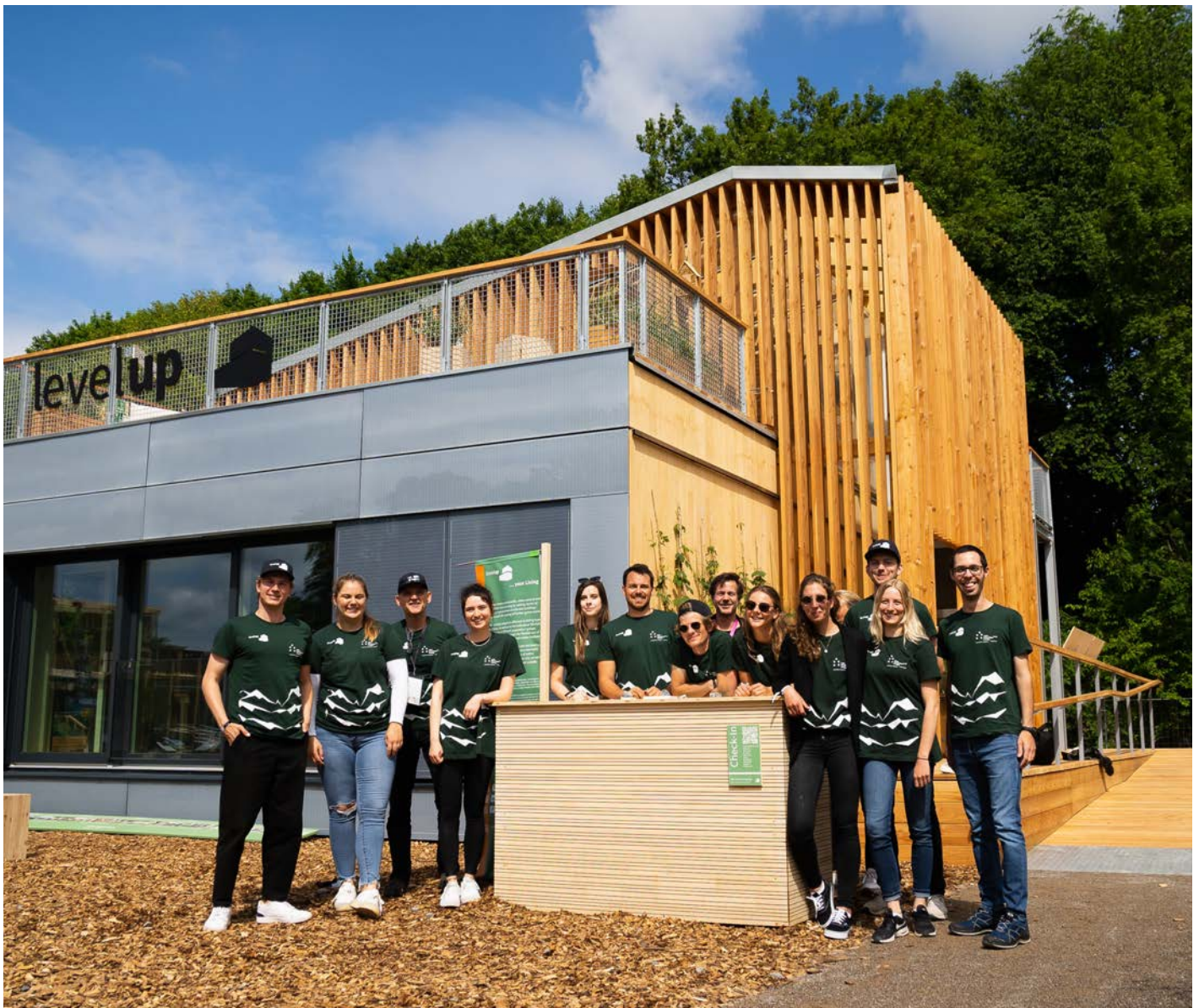
Abb. 131: Team levelup vor seiner House Demonstration Unit auf dem Solar Campus in Wuppertal im Juni 2022 – Foto: BU Wuppertal
