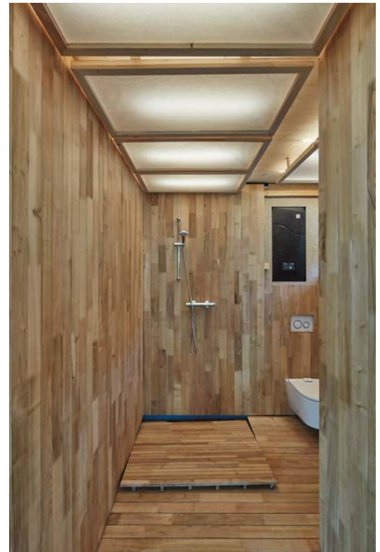
Abb. 305: Badezimmer mit herausnehmbarem Boden, Oberflächen ohne mineralische Baustoffe
