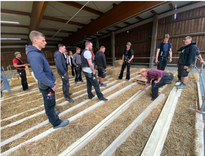
Abb. 106: Terrasse: Decke dämmen
