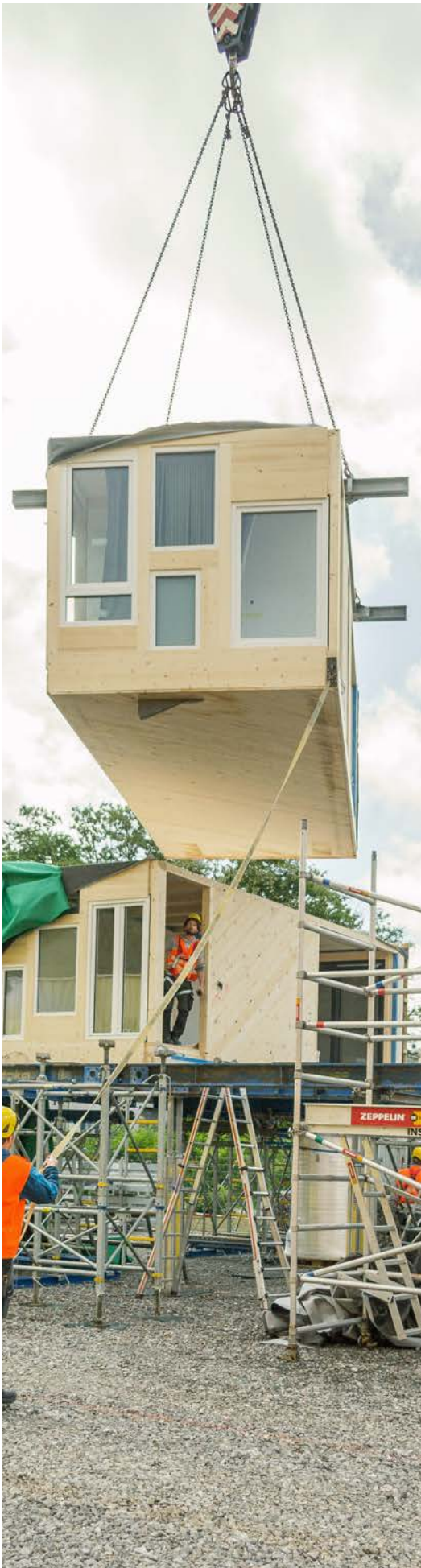
Abb. 265: Aufbau der Module der HDU in Wuppertal
