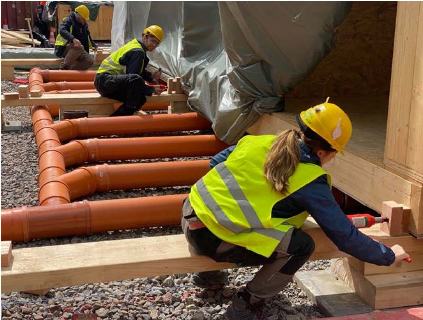
Abb. 125: Verlegung Bodenrohre
