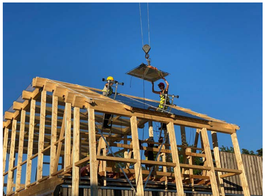
Abb. 118: Montage der Photovoltaik
