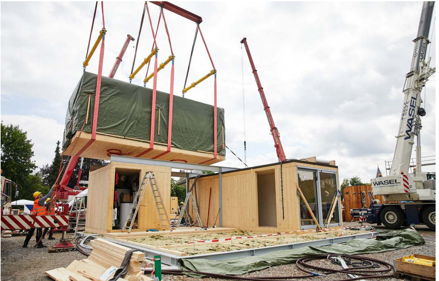
Abb. 217: Versatz des oberen Vollholzmoduls – Foto: Team MIMO
