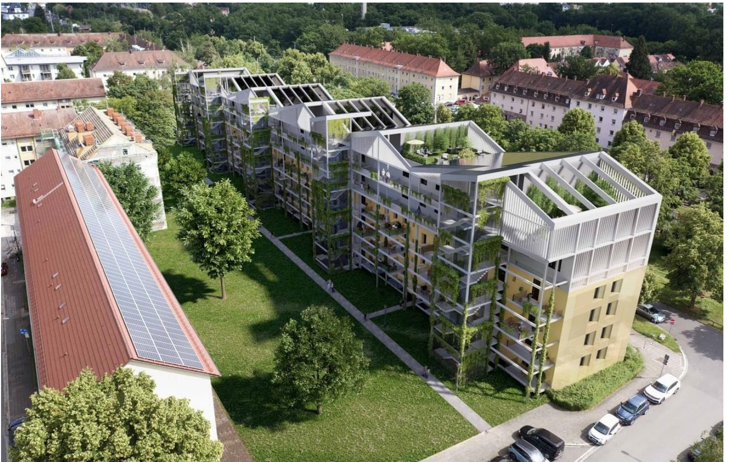
Abb. 140: Durch die neue Stahlstruktur verschmelzen Gebäudebestand und Aufstockung zu einer Einheit. Die intensive Begrünung sorgt für einen Zugewinn an Artenvielfalt und Biodiversität sowie ein gesundes Mikroklima und wirkt dem Heat Island Effekt entgegen Foto: Sigurd Steinprinz | BU Wuppertal
