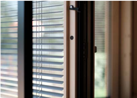
Abb. 314: Verbundfenster mit integriertem Sonnenschutz. Der Sonnenschutz und der Holzrahmen innen sind gegen Witterungseinflüsse und Wind durch die äußere Scheibe geschützt
