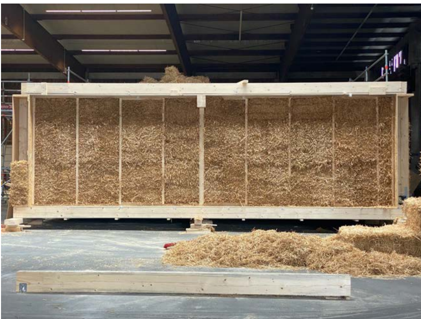
Abb. 101: Stroh in Außenwand
