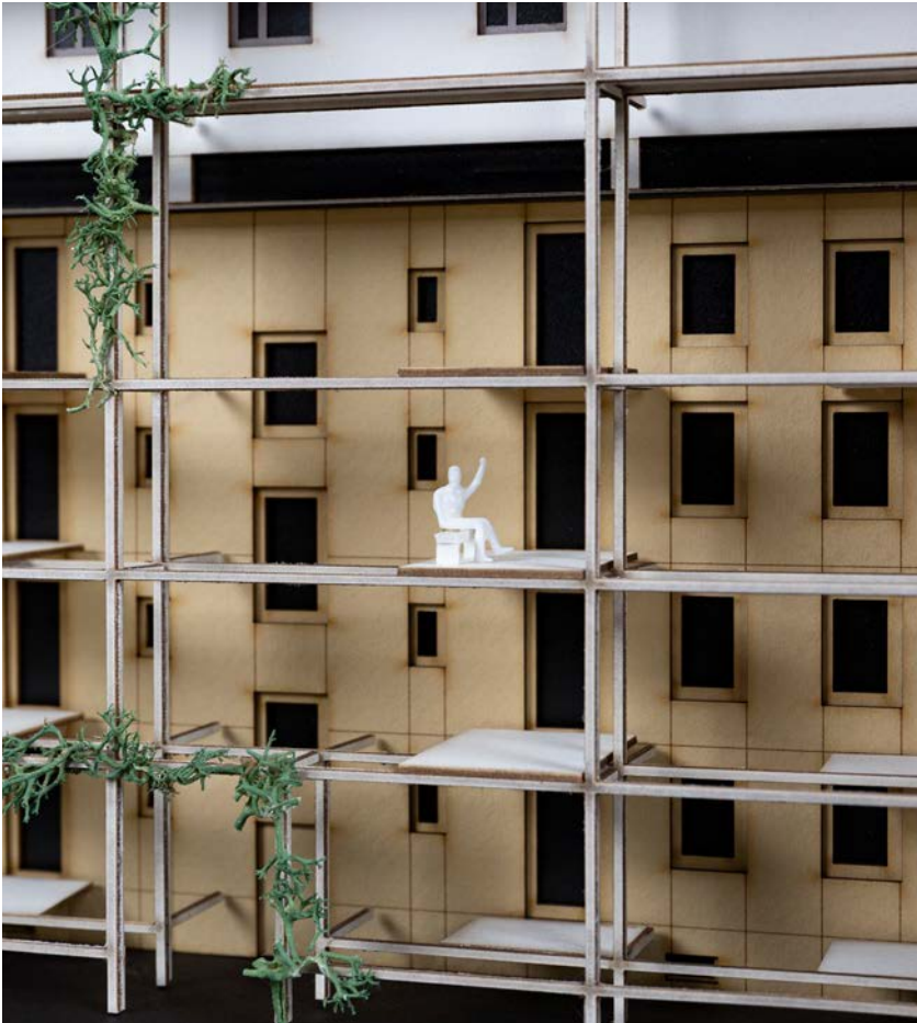
Abb. 139: Zueinander versetzte Balkone in der Stahlstruktur werten das Bestandsgebäude nachträglich auf – Foto: Sigurd Steinprinz | BU Wuppertal
