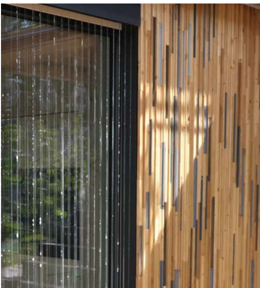
Abb. 72: Adiabate Kühlung vor Fensterflügel
