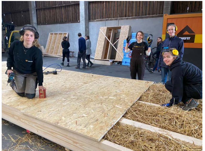
Abb. 104: Boden mit Stroh herstellen
