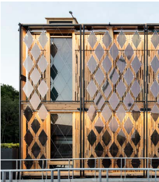
Abb. 71: Westseite mit Solarkamin Foto: Nicolai Rapp
