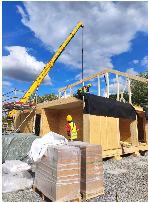
Die Module stehen, jetzt folgt der Innenausbau und der Aufbau des Wintergartens.
