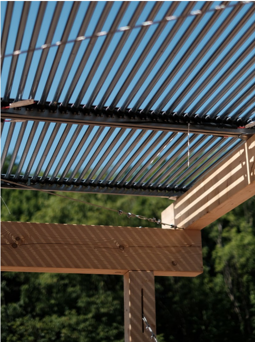
Abb. 309: Glasröhren mit Dünnschicht-Zellen als semi-transparente Photovoltaik-Module
