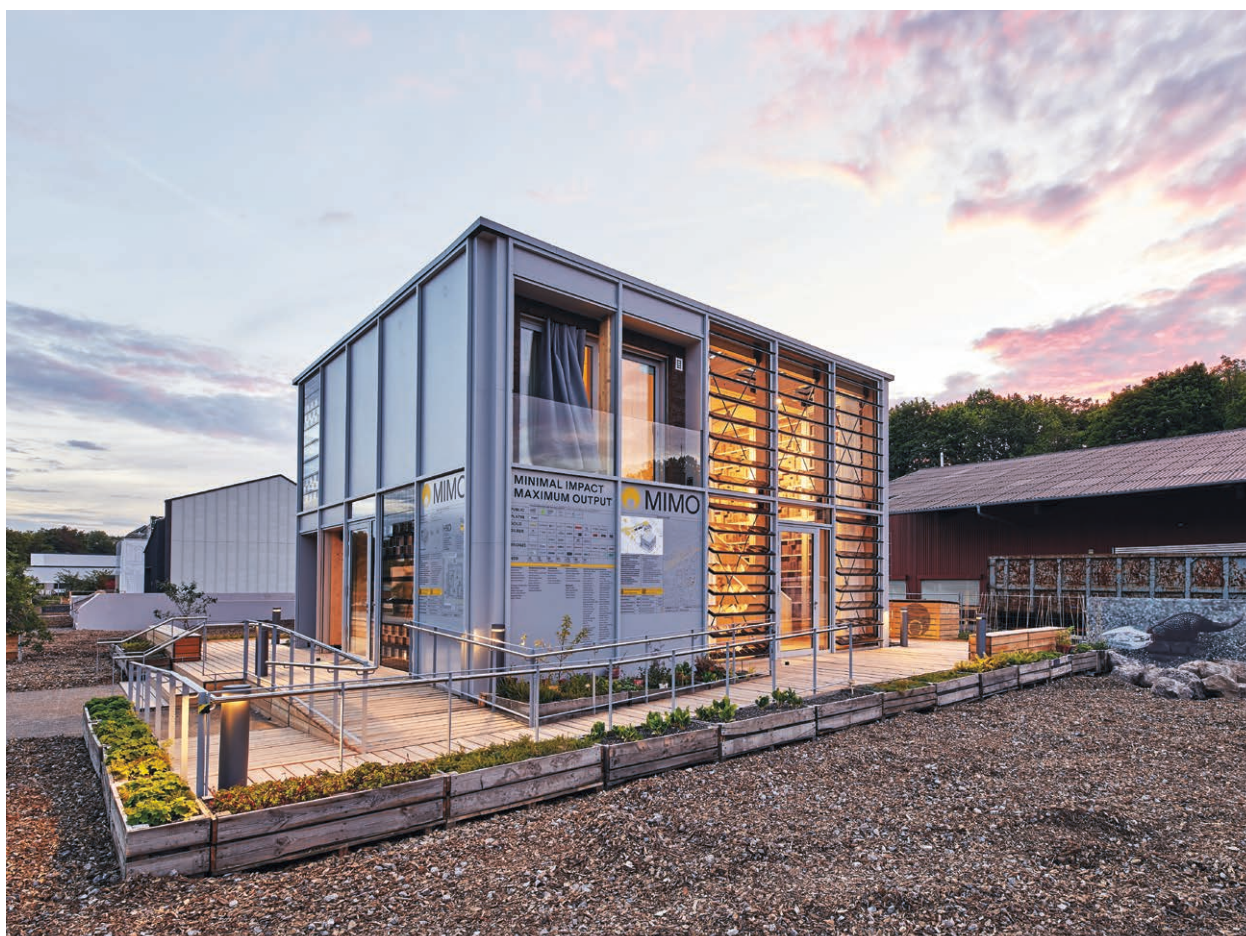
Eine voll funktionsfähige House Demonstration Unit (HDU) auf dem Wettbewerbsgelände in Wuppertal
