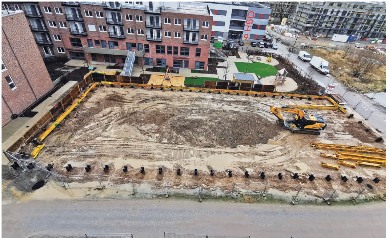
Die Baugrube des ZDD zu Beginn des Jahres 2022
