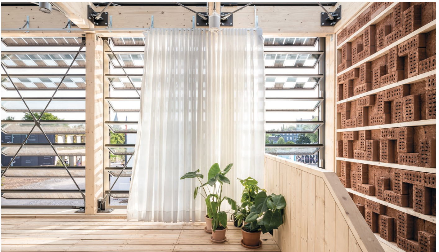
Innenansicht Obergeschoss mit geöffneter Lamellenfassade.
