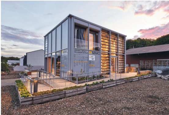
Die House Demonstration Unit des Team MIMO.
