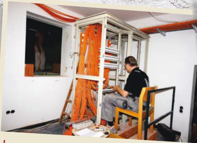
Insgesamt wurden 30.000 Meter Kabel verlegt
