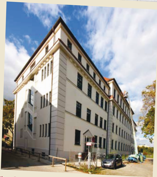
Die Schachenmeierstraße 35 erstrahlt in neuem Glanz
