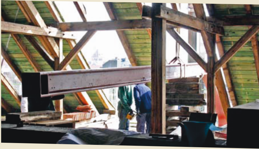
Maßarbeit: Die Stahlträger für den Dachstuhl werden mit dem Kran angeliefert
