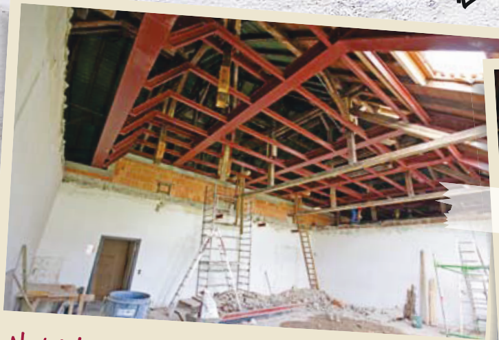
Noch ist die große Aula im 3. Obergeschoss klein
