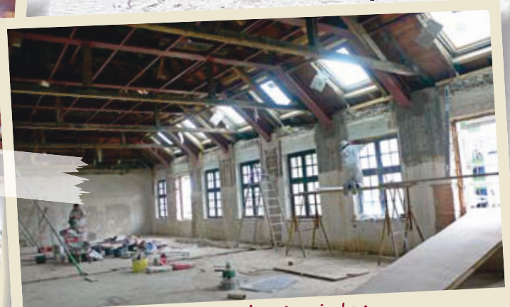
Die Aula einen Monat später, inzwischen auch mit Dachfenstern
