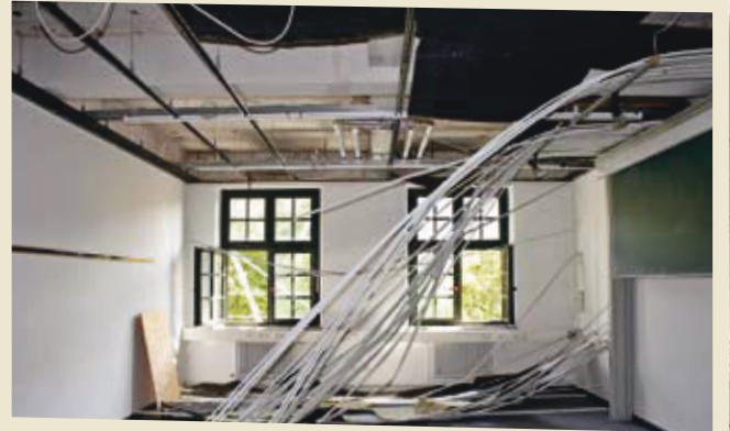
Die alten Decken müssen raus
