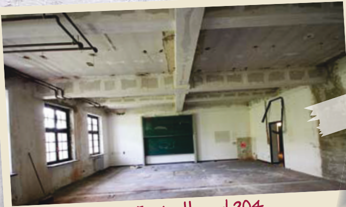
Aus zwei mach eins: Für den Hörsaal 204 im 2. Obergeschoss wurde eine Wand durchbrochen
