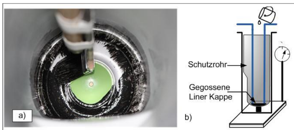
Abb.: 24 – a) Händisches Auftragen des Primers im Kopfbereich, b) Gießen der Liner Kappe.
