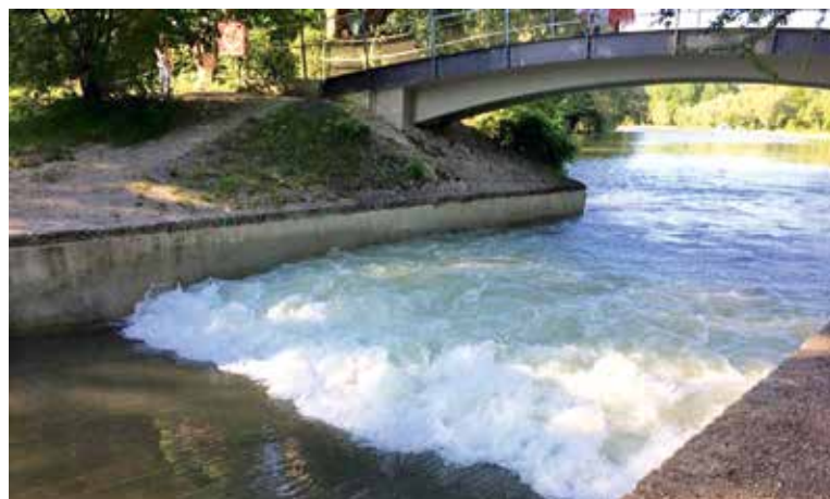
Abb. 2: Die Weißwasserwalze am 5.6.2015: Diese Welle ist nicht surfbar, sie weist kaum dynamischen Auftrieb auf.
