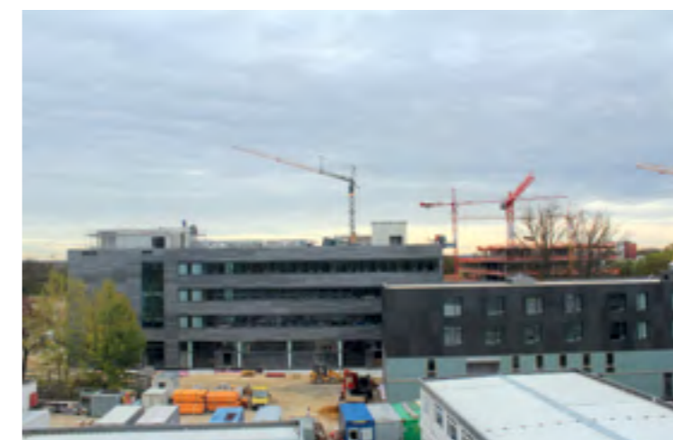
2013 Campus-Erweiterung: Die Bauarbeiten sind in vollem Gange. Die neuen Gebäude stehen schon, nur noch der Innenausbau fehlt. (Foto: Technische Hochschule Ingolstadt)
