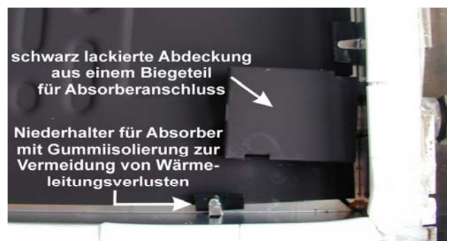
Abbildung 8: Vorlaufanschlussbereich eines Roll-Bond Absorbers (BBC Solektor)
