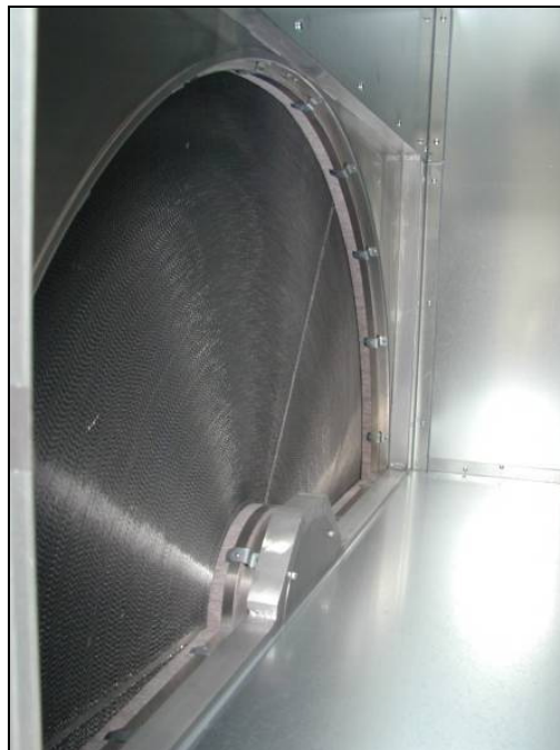
Abbildung 16: Rotationswärmetauscher
