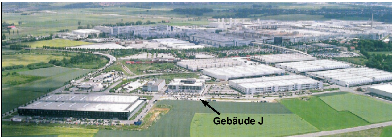
Abbildung 4 : Luftbildaufnahme GVZ Ingolstadt
