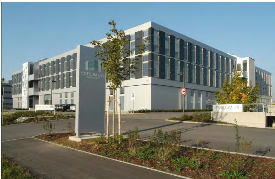
Abbildung 3 : Eingangsbereich von Gebäude J des Güterverkehrszentrums mit 18 kW p -PV-Anlage
