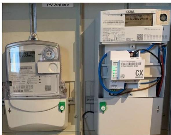
**Abbildung 6:** LMN-Verbindung zweier Zähler über ein Datenübertragungskabel
