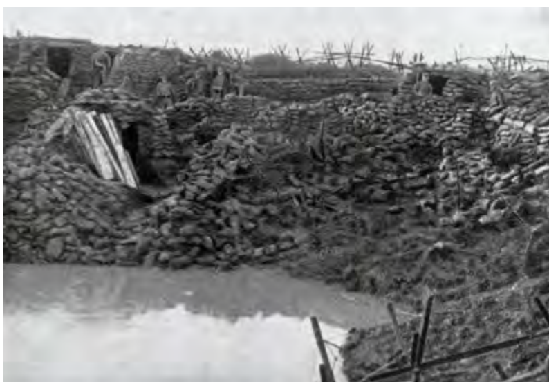
△ Abb. 124: Der vom Reserve-Infanterie-Regiment 248 besetzte und ausgebauter Trichter der englischen Sprengung vom 25. September 1915. Links im Bild: Holzbohlen zur Befestigung der Laufwege am Trichterrand. Oben am Trichterrand: Spanischer Reiter ( Frisean Horses ) mit Stacheldraht. (Quelle: ORGELDINGER 1931, S. 127)
