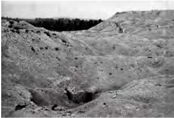
◁ Abb. 60: Tief mit Trichtern durchzogener Bereich vor den Resten der großen Bastion mit Blick auf den Kesselberg im Hintergrund. Im Vordergrund ist das durch einen oberflächennahen Trichter gesprengte Stollensystem angeschnitten, von dem aus weiter gegen den Feind miniert wurde. Am Fuß der Restbastion sind Grabenlinien zu erkennen. (Quelle: SAMMLUNG WILLIG)
