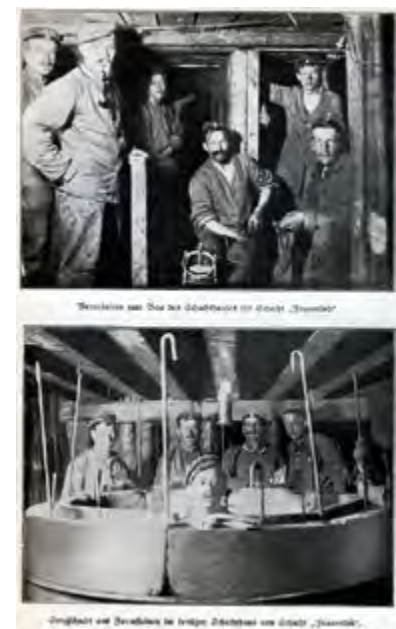
△ Abb. 93: Oben: Mineure bei den Vorarbeiten des Schachbaues für den Schacht Frauenlob. Unten: Senkschachtbau mit vorgefertigten Betonformsteinen, die durch Eisenarmierungen verbunden und mit Beton ausgegossen wurden. Die Formsteine wurden in den Mineur-Werkstätten in Tourcoing bei Roubaix (Frankreich) hergestellt. (Quelle: ANONYMUS 1918b, S. 15)
