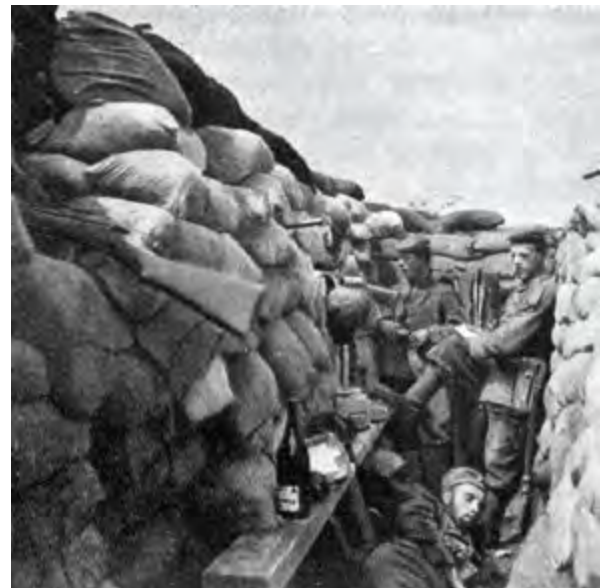
△ Abb. 123: Ausgebauter deutscher Schützengraben, teilweise aufgesetzt. Mit Sandsack-Wall auf Feindseite, wegen des hohen Grundwasserstandes im November 1915. (Quelle: ORGELDINGER 1931, S. 125)
