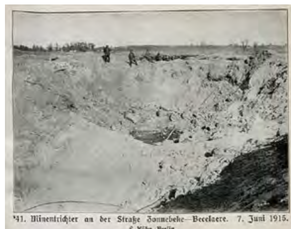
△ Abb. 152: Broodseinde Trichter, Minentrichter an der Straße Zonnebeke-Becelaere, 7. Juni 1915 (Aufnahmedatum). (Quelle: LEHMANN 1917)
