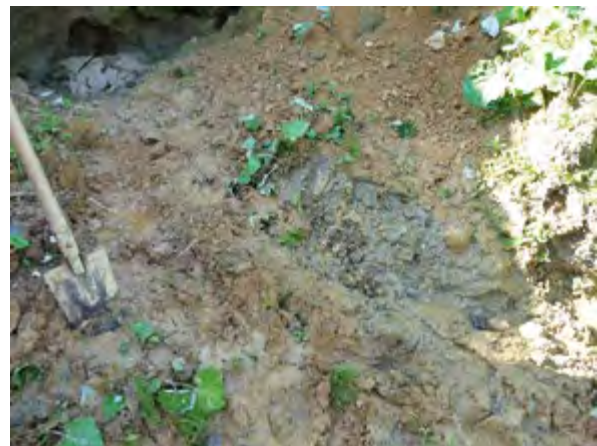
△ Abb. 138c : Quellaustritt auf der Grenze Ypern-Sand (Grundwasserleiter)/Ypern-Ton (Grundwasserstauer). In den darüber liegenden wechsellagerten Sanden und Tonen kommt es wiederholt zu schwebenden Grundwasserstockwerken. Dadurch sind die großen Wasserhaltungsprobleme und das Auftreten von Schwimmsanden leicht zu erklären. (Quelle: WILLIG 2009)
