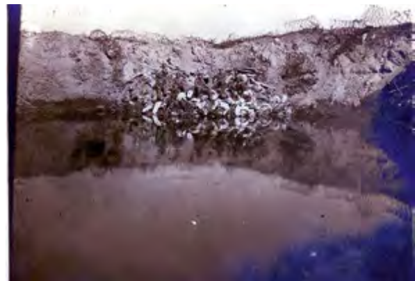
△ Abb. 62: Flacher, wassergefüllter Trichter einer oberflächennahen Sprengung vor der Großen Bastion. Der Trichterrand ist nur behelfsmäßig mit Stacheldraht gesichert. Die Mineure haben einen Stollen angesetzt und das Aushubmaterial zu einer kleinen „Landzunge“ aufgeschüttet, auf der sie für die Aufnahme posieren. (Quelle: SAMMLUNG WILLIG)
