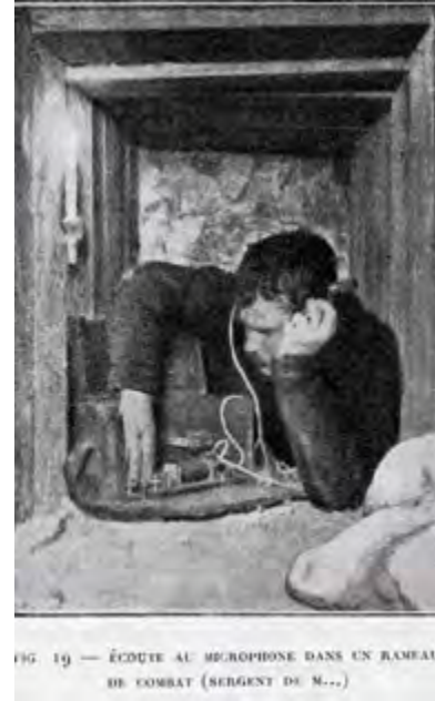
Ein Dionieroffizier hört mit einem Stethoskop die unterirdischen Arbeiten des Gegners ab. Der Apparat registriert alle Vibrationen und den Schall, der durch die Erde geht.
