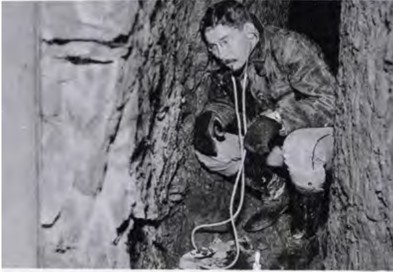
Ein Dionieroffizier hört mit einem Stethoskop die unterirdischen Arbeiten des Gegners ab. Der Apparat registriert alle Vibrationen und den Schall, der durch die Erde geht.
