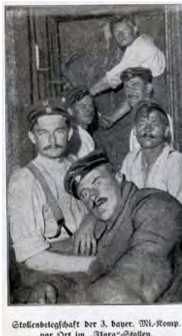
◁ Abb. 90: Mineure der 3. Bayerischen Mineur-Kompagnie, die im Stollen Flora vor Ort arbeiten. Im Regelbetrieb gewinnt ein Mann am Stollenkopf das Material (Hauer), das dann von einem bis zwei Männern in Säcke oder in eine Transportlore, auch Hunt genannt, verladen wird. Ein bis zwei weitere Pioniere transportieren den Hunt dann zur Winde. Mit dieser wird der Abraum zu Tage gefördert. Vor Ort kann auch die Stollenverkleidung mit Schurzholz abschnittsweise durchgeführt werden. (Quelle: ANONYMUS 1918b, S. 14)
