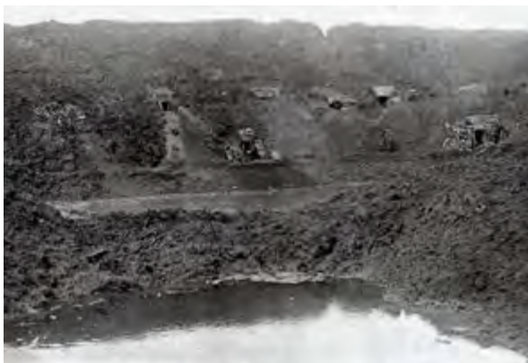
△ Abb. 61: Steile Wand eines großen Sprengtrichters mit minierten Stollen an der Großen Bastion/ The Bluff . Zu erkennen sind Stolleneingänge. Zum Rand des Abhanges führen Wege, die wiederum zu Verteidigungsstellungen am Rand münden. Im Vordergrund ist ein wassergefüllter, älterer Trichter zu erkennen. Der hintere Trichter entstand wahrscheinlich bei der großen Sprengung der Deutschen am 22. Januar 1916 (vgl. Tab. 4 ). (Quelle: SAMMLUNG WILLIG)
