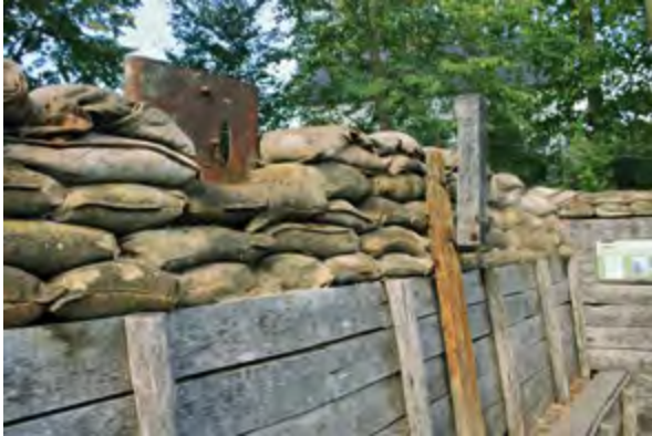
△ Abb. 315: Belgischer Schützengraben mit Grabenspiegel und Grabenschild. (Quelle: WILLIG; Foto aufgenommen im „Memorial Museum Passchendaele 1917“, Zonnebeke)
