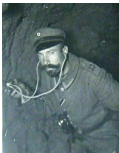
△ Abb. 192b: Fotografie eines Mineurs des Pionier-Bataillons 13, der mit einem Stethoskop nach Miniergeräuschen horcht. (Quelle: SAMMLUNG WILLIG)
