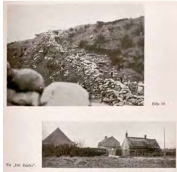
△ Abb. 71: Oben: Deutscher Schützengraben an der Böschung Eisenbahnlinie Ypern–Comines zur Höhe 60. Unten- Blick auf die Drei Häuser. (Quelle: BOSSERT 1935)
