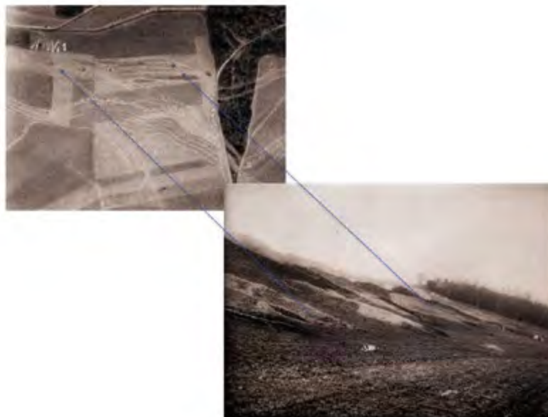
△ Abb. 277: Luftaufnahme von Stolleneingängen am Hinterhang mit Schutthalden. Rechts unten ist eine Schrägaufnahme eines solchen Geländeabschnittes zu sehen. (Quelle: KOMMANDIERENDER GENERAL DER LUFTSTREITKRÄFTE 1917b, Kapitel A., Abb. 15 )
