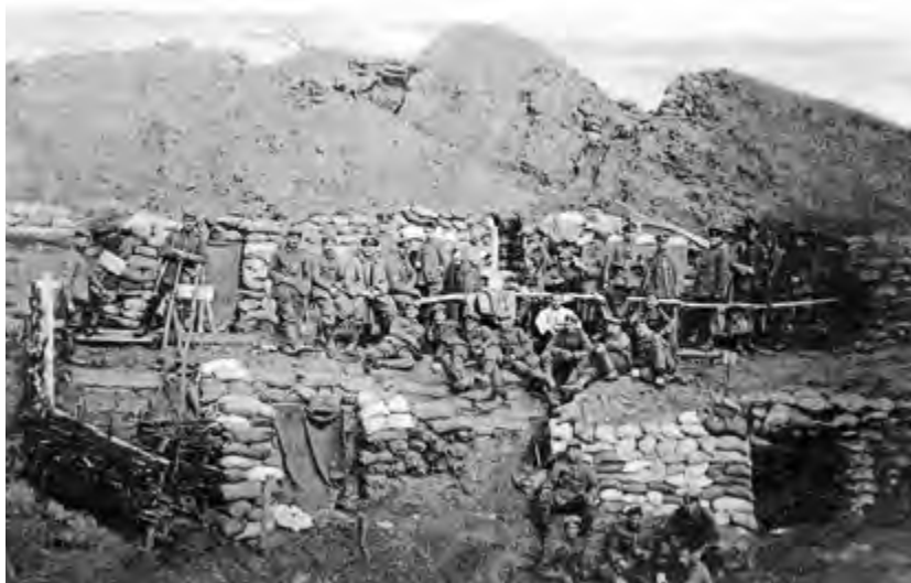
△ Abb. 24: Der bereits ausgebaute Sprengtrichter vom 14. März 1916. Am Trichterrand sind Stellungen für Schützen und Handgranatenwerfer zu erkennen. Im Vordergrund sind Unterstände zu sehen. Die Soldaten haben sich für das Foto auf den befestigten Laufwegen im oberen Trichterbereich versammelt. Solche Trichterfotos waren beliebte Motive für Feldpostkarten (Foto: SAMMLUNG WILLIG).
