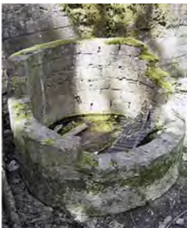
△ Abb. 221: Senkschacht Dietrich im Bereich Petite Bois aus selbstgefertigten Formsteinen, die mit einbetonierten Armierungseisen verbunden wurden (siehe auch Abb. 222 ). Geschützt wurden die Schachtköpfe durch betonerte Minenhäuser mit dicker Betondecke, hier weggesprengt. (Quelle: WILLIG)
