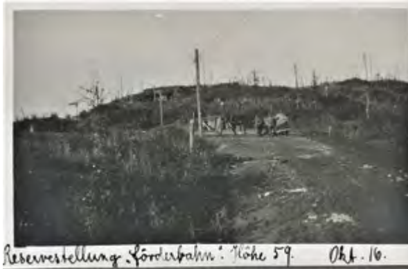
△ Abb. 63: Förderbahn Reservestellung Höhe 59 am Kanalknie (siehe Abb. 42 ). Das Foto entstand im Oktober 1916. (Quelle: SAMMLUNG WILLIG)
