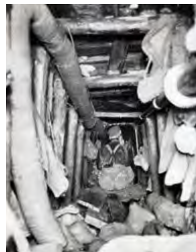
△ Abb. 194: Deutscher Mineur beim Horchen am mit Lutten (Rohre) belüfteten Stollenkopf. In den speziell angesetzten unregelmäßigen Horchpausen unterblieben natürlich alle eigenen Minierarbeiten und die Lüftung wurde abgestellt. (Quelle: SCHULZ 1926, S. 9 der Bildtafeln)
