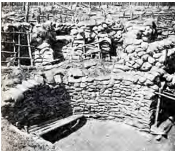
△ Abb. 102: Von den Deutschen erobert und ausgebauter Trichter 4. und 5. März 1915. Wahrscheinlich handelt es sich um den am 4. März 1915 von den Engländern gesprengten Trichter, der 'bastionsartig' ausgebaut wurde. (Quelle: GLÜCK & WALD 1929, S.103)
