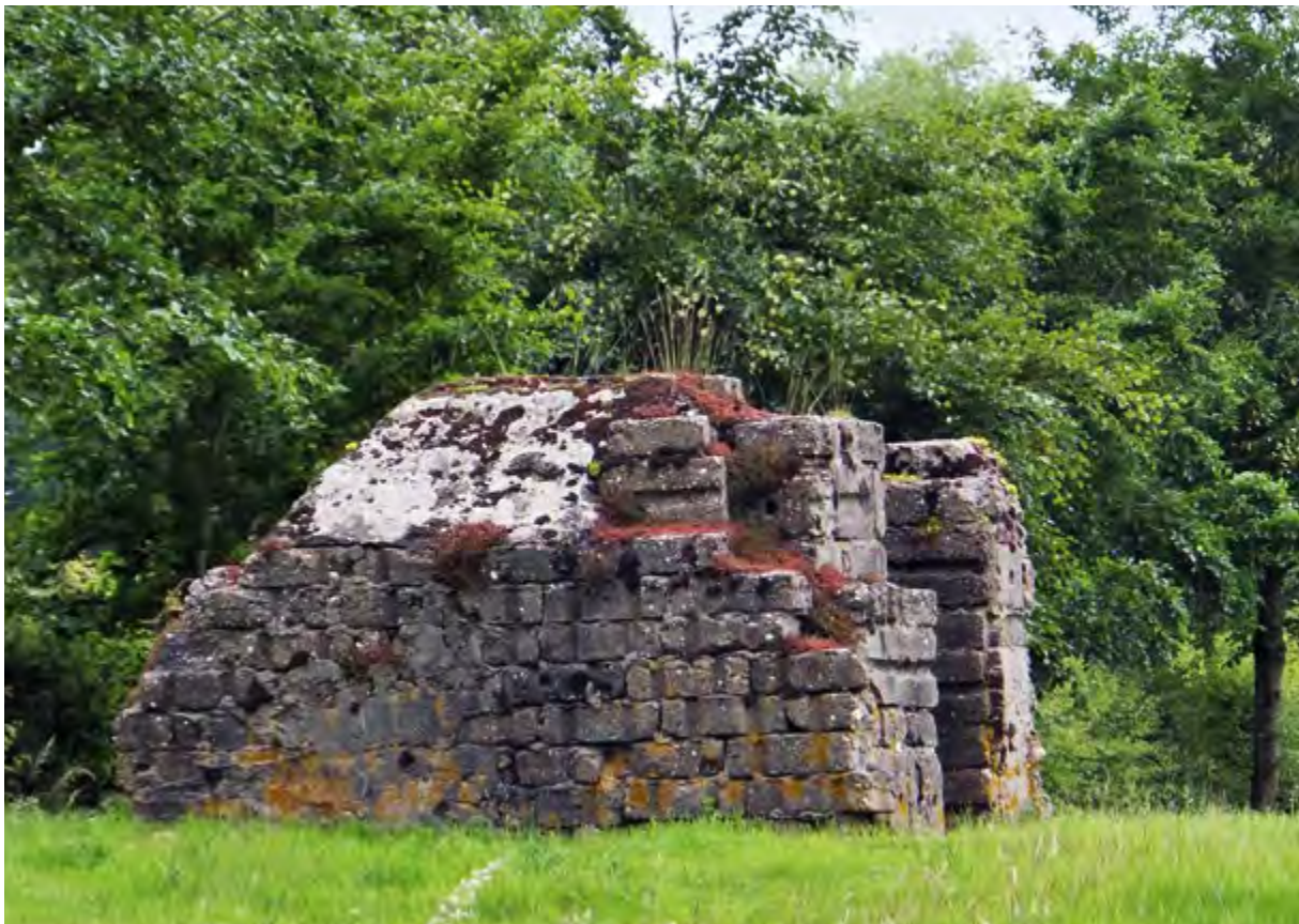
△ Abb. 52: Heute erstreckt sich im Bereich Schloss und Schlosspark Hollebeke bis zur Kleinen Bastion ein weitläufiger Golfplatz. Das Foto zeigt die aus vorgefertigten Betonsteinen gebauten deutschen Bunker. Die restlichen deutschen Anlagen, insbesondere die Schachtköpfe (Abb. 45, 46) sind anscheinend planiert worden. (Quelle: WILLIG 2020)
