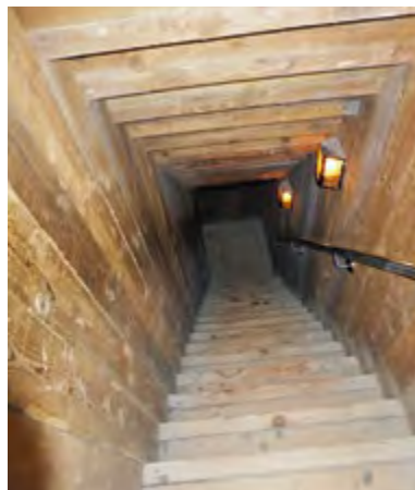
△ Abb. 308: Schleppschacht (Treppenschacht) zum dugout. (Quelle: WILLIG; Foto aufgenommen im Memorial Museum Paschendaele 1917, Zonnebeke)
