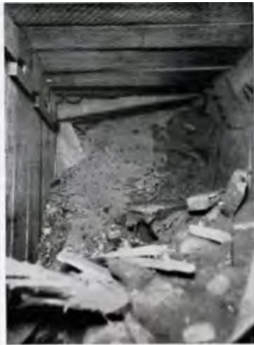
Abb. 8a. Zerstörte Minegasse, durch eine feindliche Mine, rechts vom Betrachter zu denken abgegründet.
