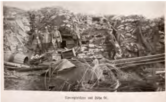
△ Abb. 74: Ausgebauter Sprengtrichter auf Höhe 60. Zu erkennen sind Unterstände und die Befestigung des Trichterrandes sowie verschiedene Baumaterialien. (Quelle: BOSSERT 1935, Bildseiten nach S. 212)
