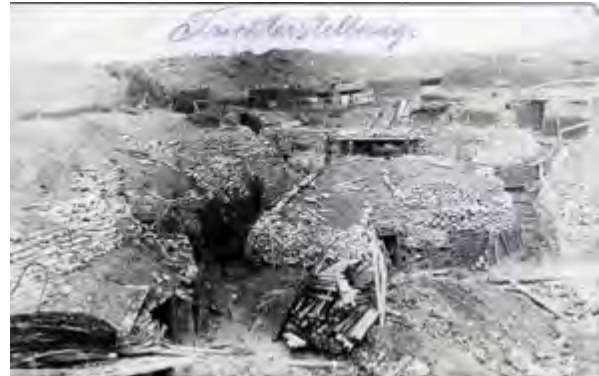
△ Abb. 32b: Die Feldpostkarte zeigt den Trichter III. Carl. Im Vordergrund liegen Schurzhölzer für den Bau von Angriffs- und Wohnstollen. (Quelle: SAMMLUNG WILLIG)
