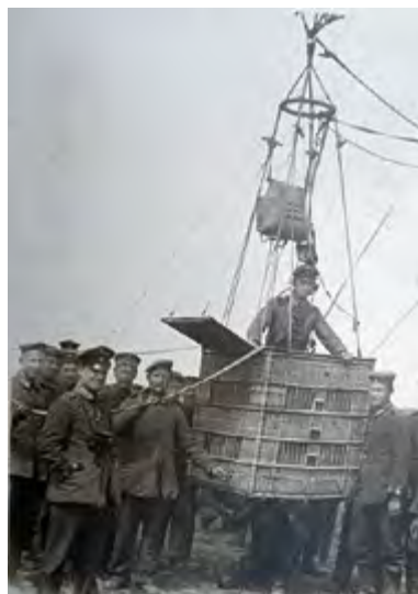
△ Abb. 256: Korb eines Fesselballons mit Fallschirmbehälter über dem mit einem Sprechsatz ausgerüsteten Beobachter. (Quelle: SAMMLUNG WILLIG)
