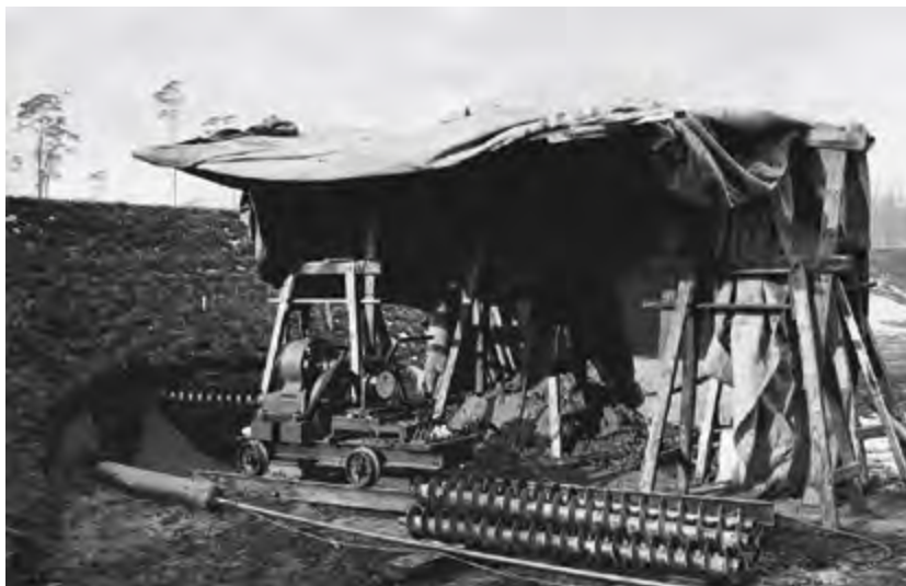
△ Abb. 80: Versuchsmaschine einer Großen Erdbohrmaschine für Minierarbeiten der Siemens-Schuckert-Werke GmbH (BayHStA/Abt IV-Techn. Sonderformationen und Wirtschaftsformationen [WK] 456).
