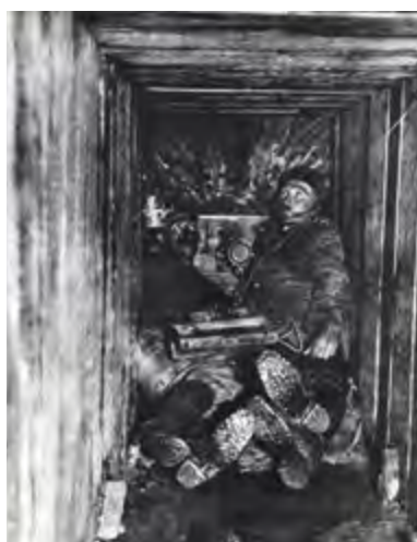
△ Abb. 193: Deutsche Horchposten vor Ort im mit Schurzholz ausgebauten Stollen. Gut zu erkennen sind die genagelten Schuhsohlen der Mineure. Wenn die Schuhe nicht umwickelt oder ausgezogen wurden, war das Laufen im Stollen je nach Schalleitfähigkeit des Gesteines recht weit zu hören. (Quelle: SAMMLUNG WILLIG)
