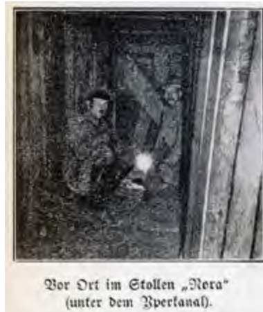
△ Abb. 50: Vor Ort im Stollen Nora unter dem Yperkanal. Der Stollenkopf ist mit Holzbalken verkeilt. Solche Verkeilungen werden regelmäßig am Ende einer fertig verdämmten Minenladung angebracht. Der Stollen ist mit Schurzholzrahmen vollständig verkleidet. (Quelle: ANONYMUS 1918b, S. 23)
