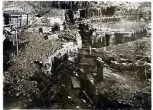
△ Abb. 218: Ausgebauter Trichter (wahrscheinlich Trichter 2) einer der Sprengungen vom 27. Juni 1916 mit Eingängen zu deutschen Schacht-/Stollenanlagen. So konnte man nach wenigen Metern in ungünstigem Gestein im Ypern-Ton minieren ( Abb. 217 ). Deutlich zu erkennen ist ein Soldat, der auf einem sogenannten Donnerbalken sitzt. (Quelle: SAMMLUNG WILLIG)
