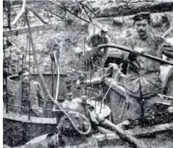
△ Abb. 224: Betonsenschacht Gerhard. Im Vordergrund ein Mineur an der Handpumpe. Hinten sieht man die Stahlverschalung mit Miniereisen. (ANONYMUS 1918b, S. 23)
