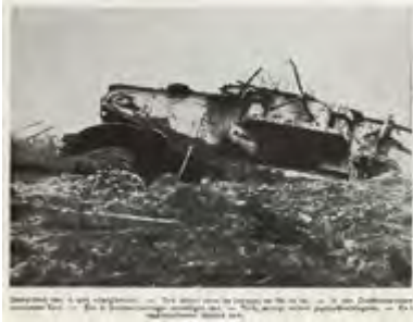
△ Abb. 283: In Drahthindernissen gefangen und zerstörter Mark-Panzer. Die linke umlaufende Kette ist gerissen. (Quelle: SAMMLUNG WILLIG)
