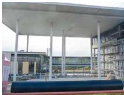
Die SHL-Baustelle im Oktober 2010
