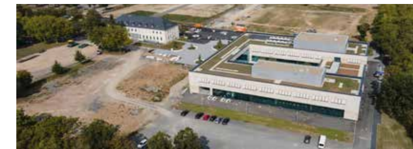
Luftbild des Neubaus in der Konrad-Zuse-Straße 2 in Schweinfurt (Foto: FHWS/R. Anderl)
