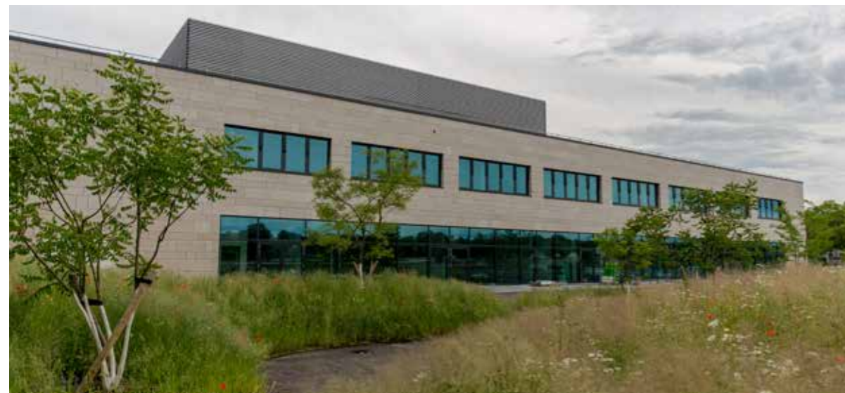
Neubau der Hochschule auf dem Gelände der ehemaligen Ledward Baracks, in denen die Fakultät Wirtschaftsingenieurwesen im Jahr 2020 Räumlichkeiten bezogen hat. (Foto: FHWS/S. Friese)
