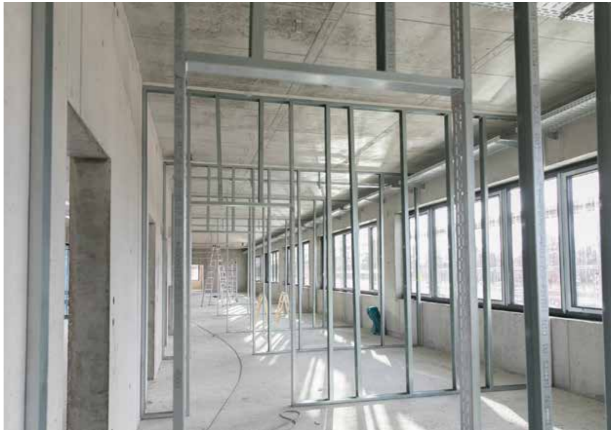
Im Jahr 2018 feierte die FHWS mit rund hundert Gästen die Grundsteinlegung des neuen Hochschulgebäudes auf dem ehemaligen Areal der Ledward Barracs. 4.100 Quadratmeter Nutzfläche auf zwei Etagen stehen künftig Professoren, Mitarbeitern sowie Studierenden in Hörsälen, Seminarräumen, Labors und Büros zur Verfügung. (Fotos: FHWS/Friese)
