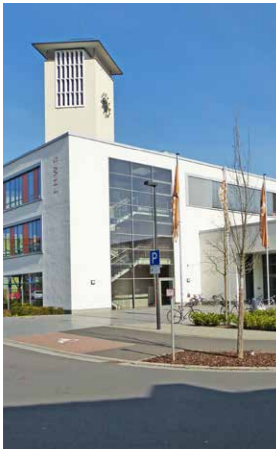
Hochschulgebäude Konrad-Geiger-Straße 2 in Schweinfurt (Foto: FHWS)
