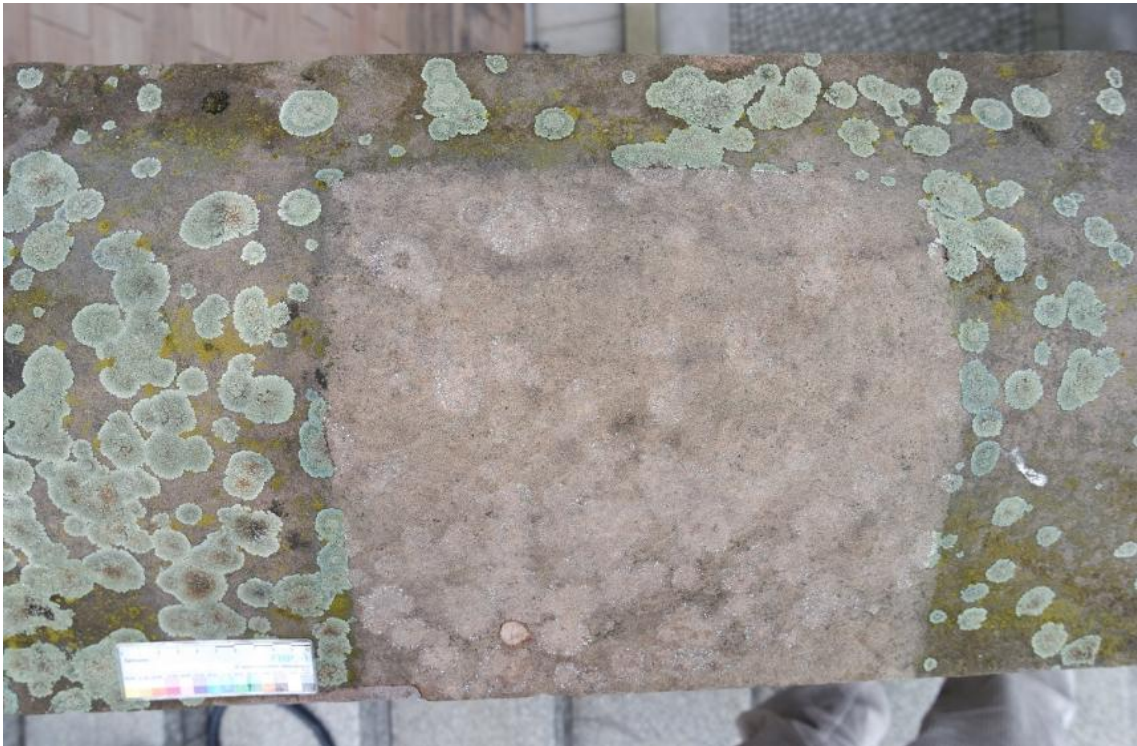
Abb. 26: Endzustand Reinigung mit Mikrodampfstrahlgerät.
