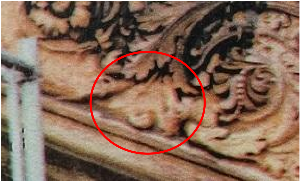
Abb. 10: Detail Brüstungsplatte V1 1996
