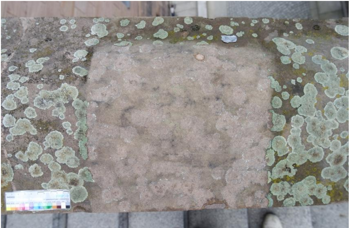
Abb. 25: Endzustand Reinigung mit Bürste.
