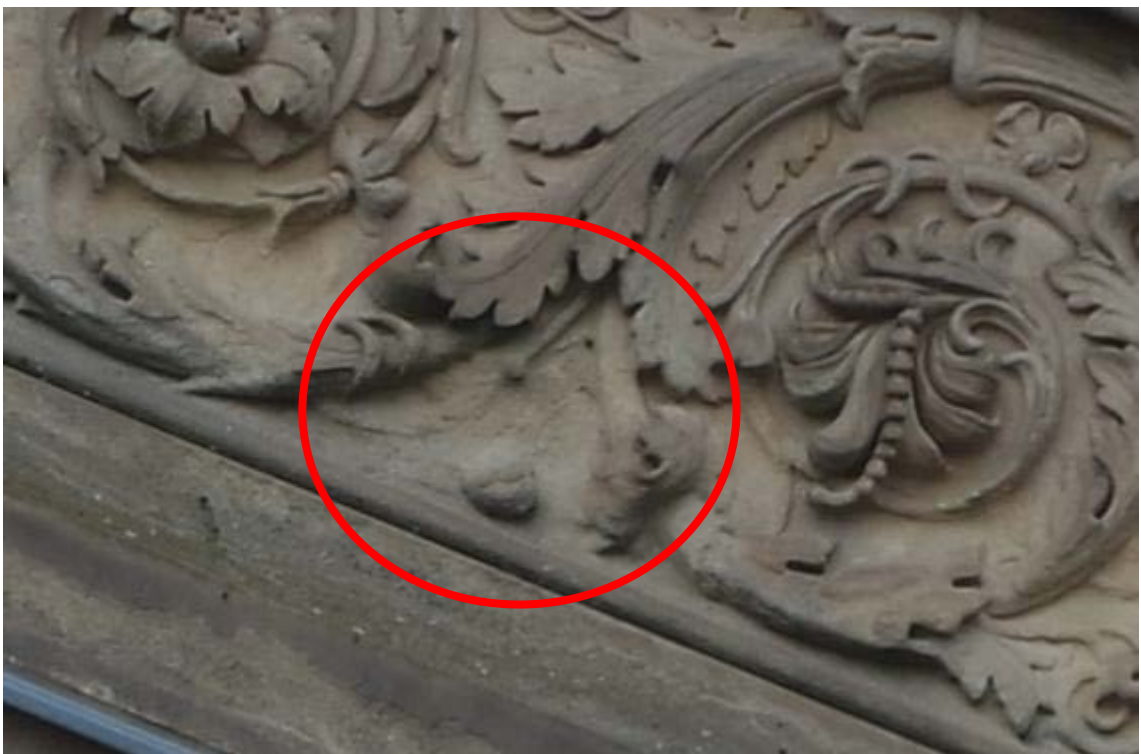
Abb. 11: Detail Brüstungsplatte V1 2015
