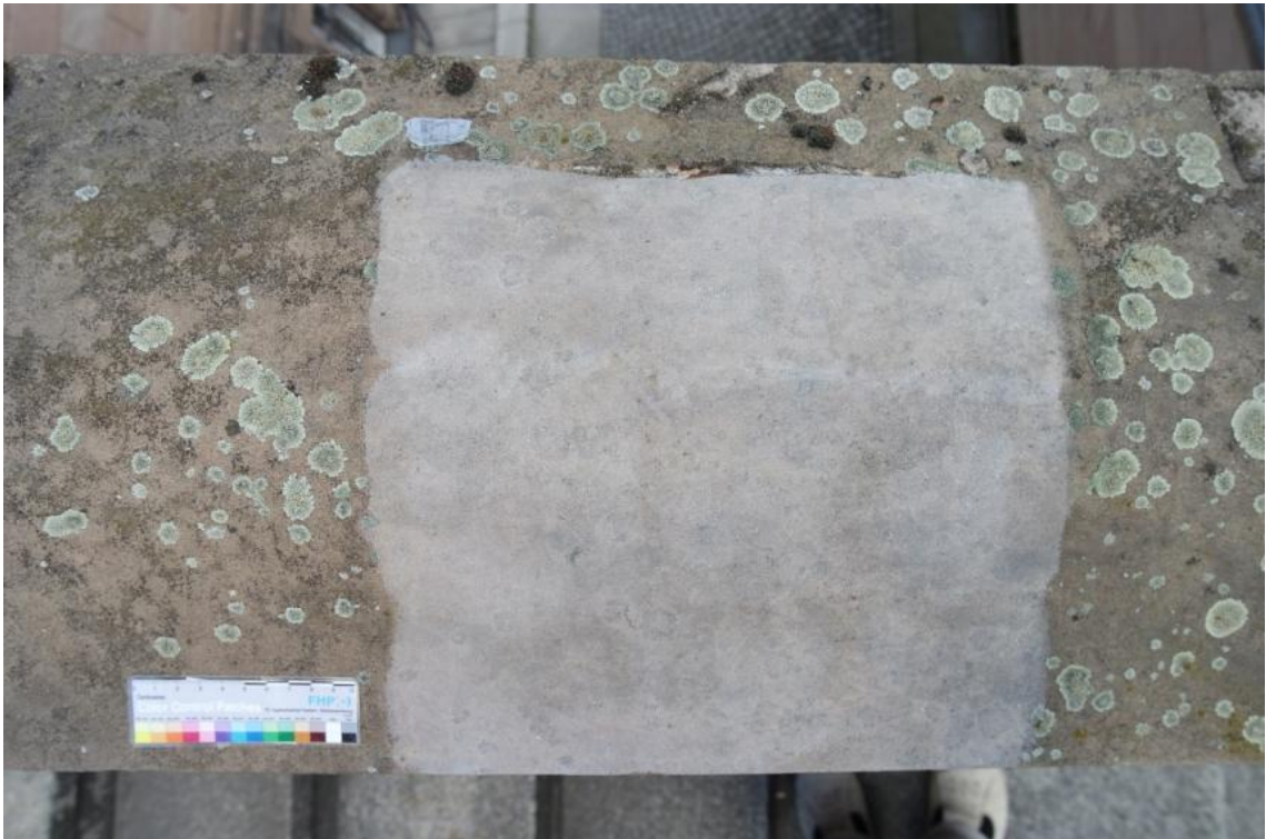
Abb. 28: Endzustand Reinigung mit dem Mikrodampfstrahlgerät und Behandlung mit Titandioxid.
