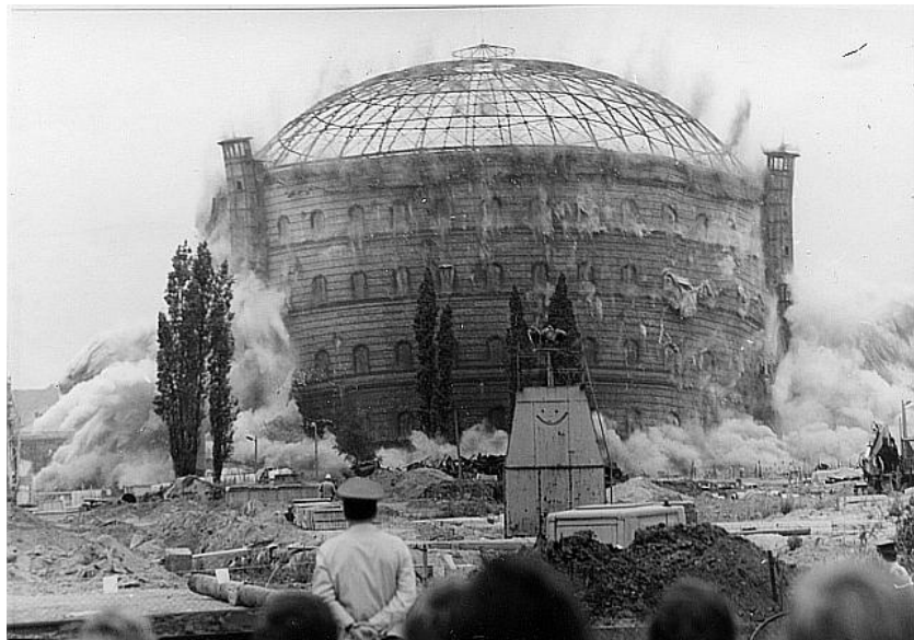
Abb. 4: Sprengung der Gasometer.
