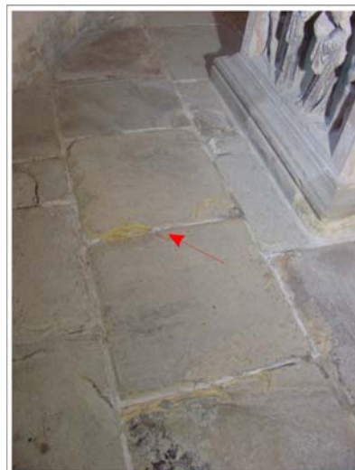
Abb. 6: Probenahmestelle an einer der Fußbodenplatten um die Tumba in der Burgkapelle.
