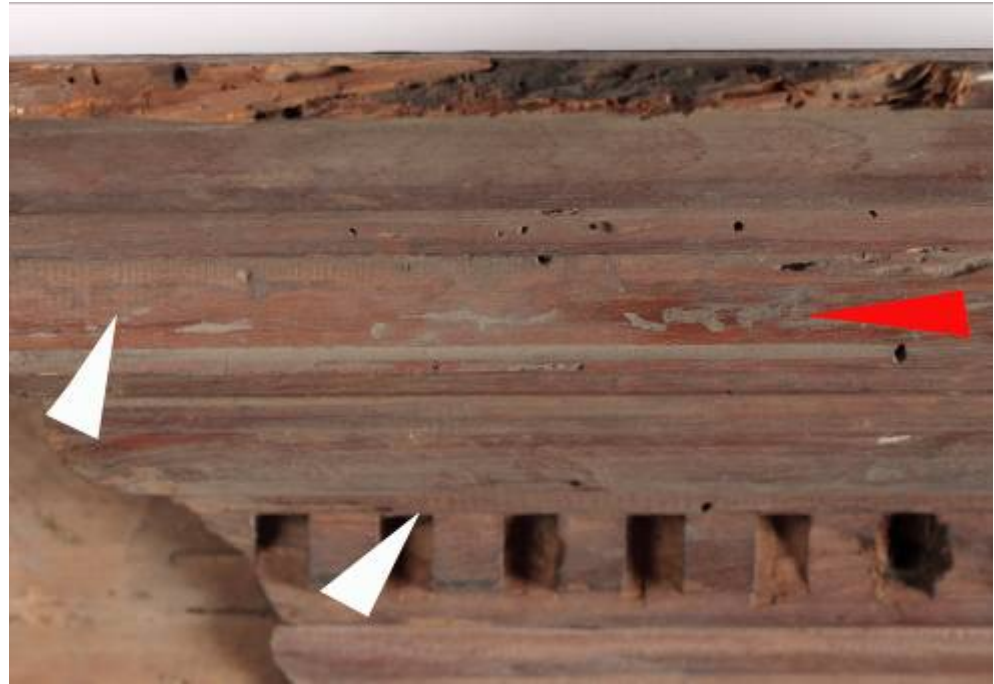
Abb. 53, Hobelmarker (weiß) und geöffnete Frazgänge (rot) von Überarbeitung – oberes Profil des Gesimses über Tafel V
