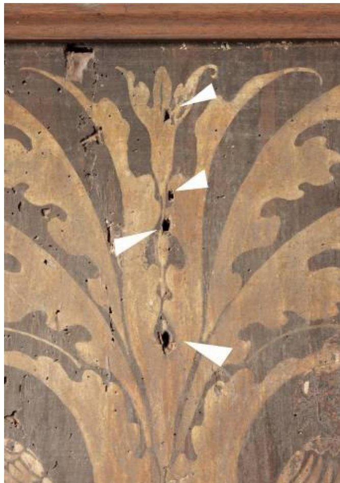
Abb. 64, Fassung der Tafel VI – Nagellöcher im oberen Bereich
