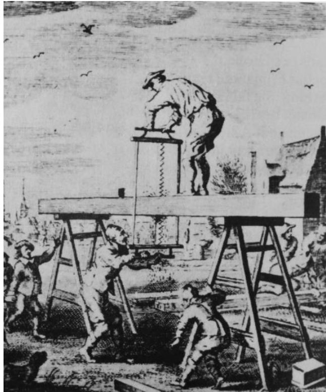
Abb. 46, Führung einer Klobsäge zur Herstellung von Balken und Brettern
