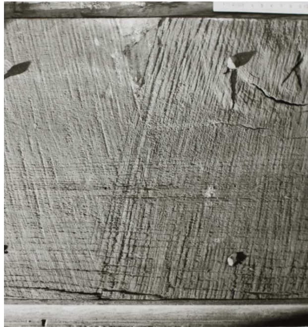
Abb. 52, Sägespuren, vermutl. Klobsäge - Regalunterboden in der Goldene Kammer der Kirche St. Ursula/ Köln, um 1700
