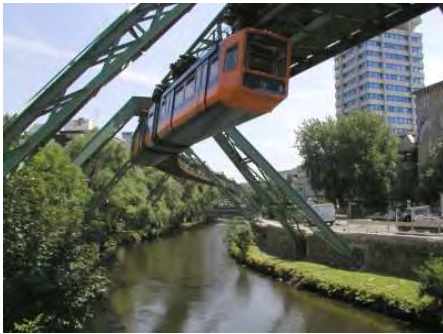
Abb. 19 Teilabschnitt der Schwebebahn. Quelle: www.stadtnetz-wuppertal.de (Stand 25.02.2010)
