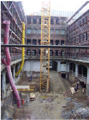
Abb. 2 Die Baustelle auf dem Innenhof Richtung Süden.
