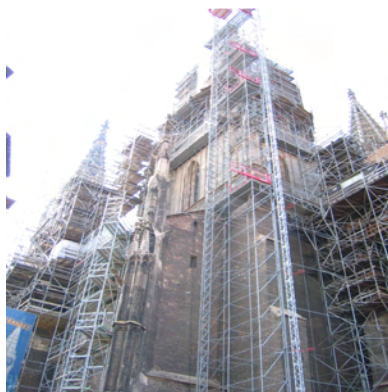
Abb. 16 Der Ulmer Münster während der Sanierungs- und Restaurierungsarbeiten. Foto: Dipl.-Rest. Martin Kaufmann.
