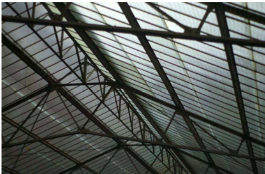
Abb. 6 Die Konstruktion des Oberlichtes: der Firstbinder, die Glasleisten und die Fachwerkbinder. 57 Foto: STRABAG Real Estate GmbH.
