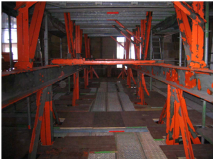
Abb. 17 Instandsetzung der Altbeschichtung mit Bleimennige-Grundierung. Foto: Dipl.-Rest. Martin Kaufmann.
