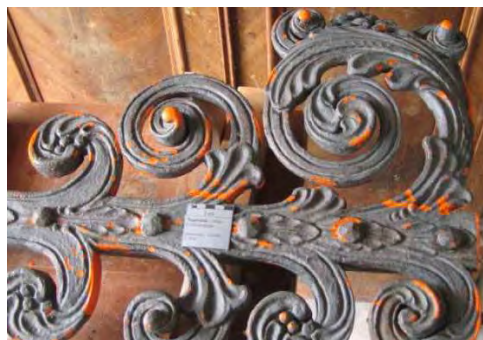
Abb. 22 Partieller Korrosionsschutz mit Bleimennige. Foto: Dipl.-Rest. Christian Bode.
