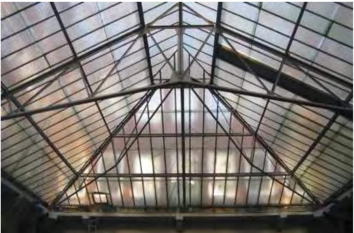
**Bild 6**      Ein Walmträger an der Stirnseite in südlicher Ausrichtung.
