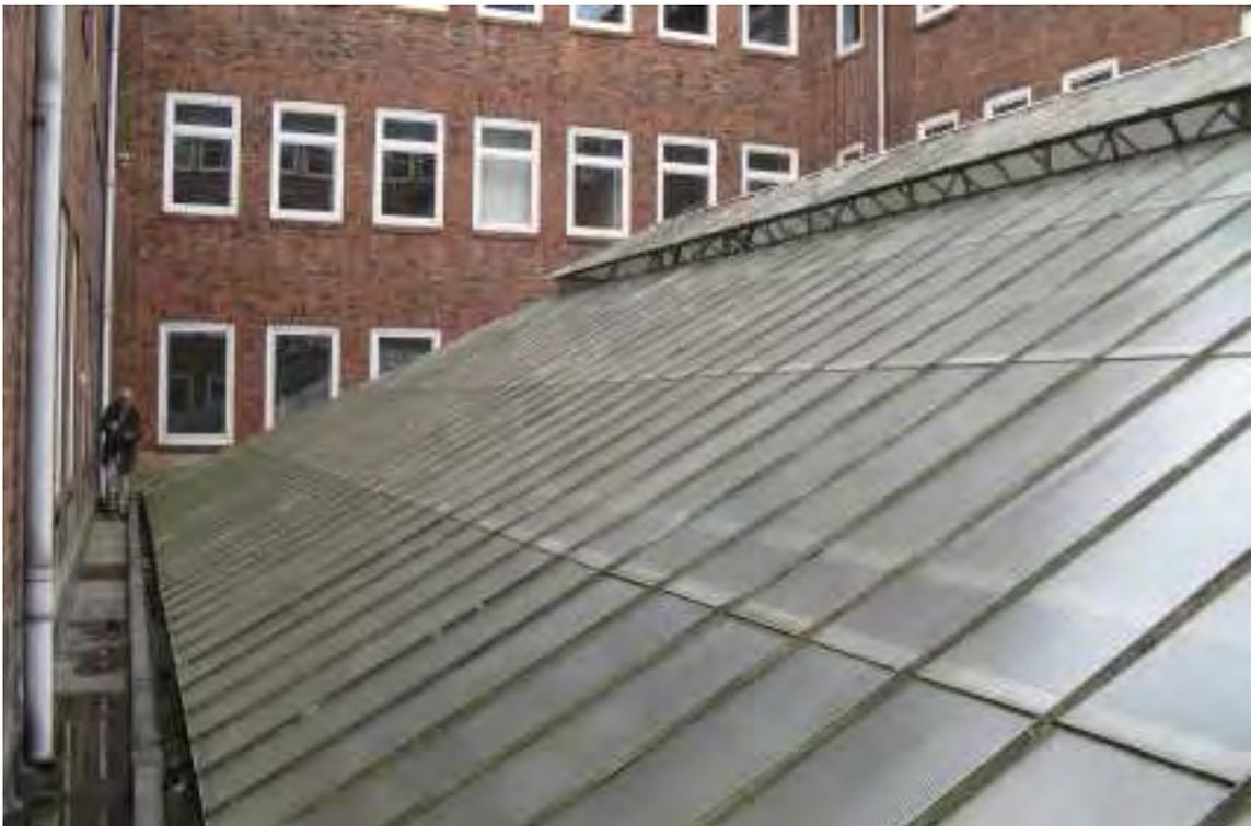
**Bild 4** Abstand zwischen der Überdachung des Oberlichtes und der darunter liegenden Konstruktion (Hutze). Foto: Stefan Lasch-Abendroth
