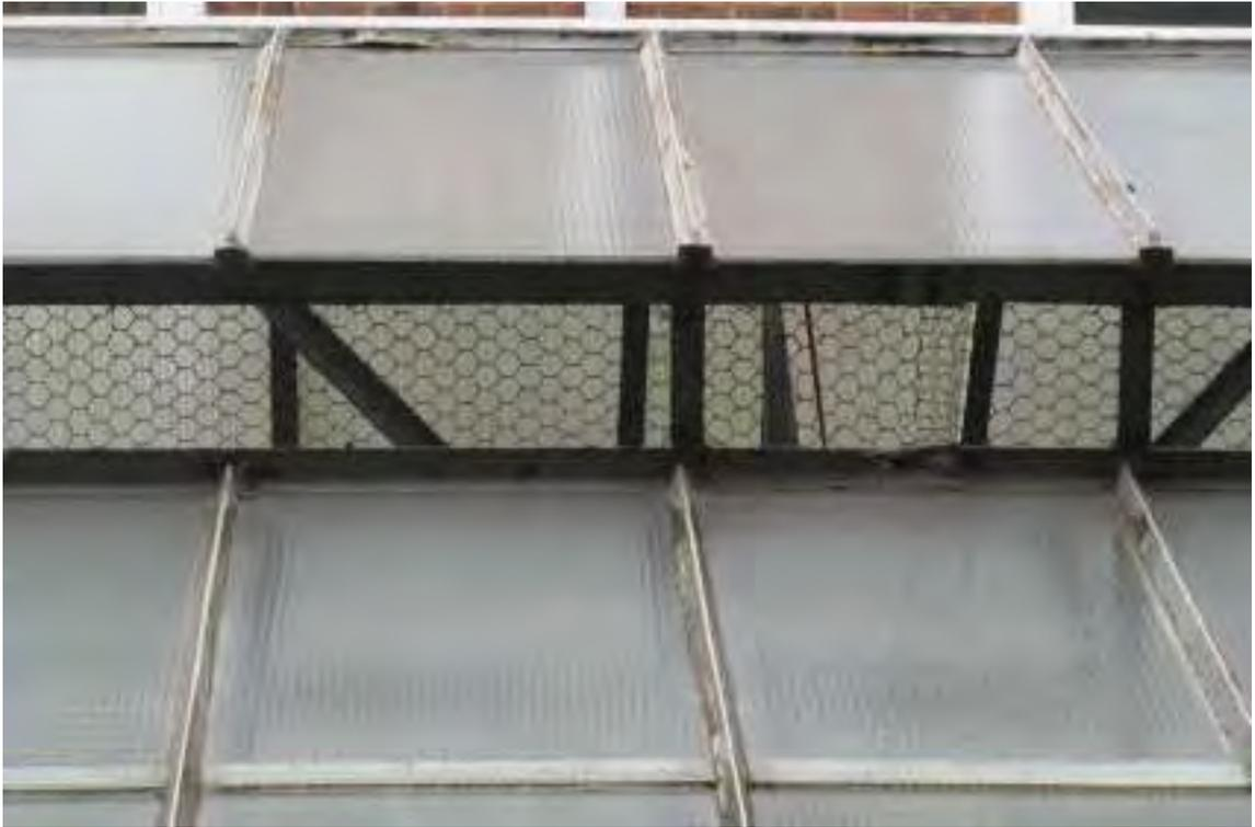
**Bild 9** (Abb. 7) Das Lüftungsgitter des Oberlichtes. Die Kittfasen zwischen Glas und Glasleisten.
