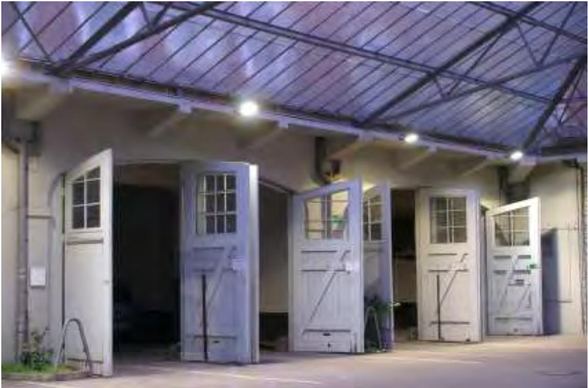
**Bild 22** Teilansicht des Innenhofes. Remisentore und Dachtragwerk. Die Traufanker befestigen die Traufpfetten auf dem horizontalen Gesims.
