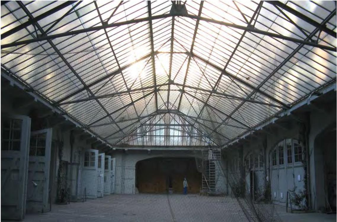
**Bild 3** Das Dachtragwerk liegt auf einem den Hof horizontal umlaufenden Traufgesims aus Stahlbeton auf. Konsolen, angebracht in regelmäßigen Abständen, bieten zusätzliche Unterstützung. Das Foto wurde zu Beginn der Demontage aufgenommen. Das zum Schutz vor Laub gespannte Netz ist bereits zum Teil abgenommen. Foto: Stefan Lasch-Abendroth
