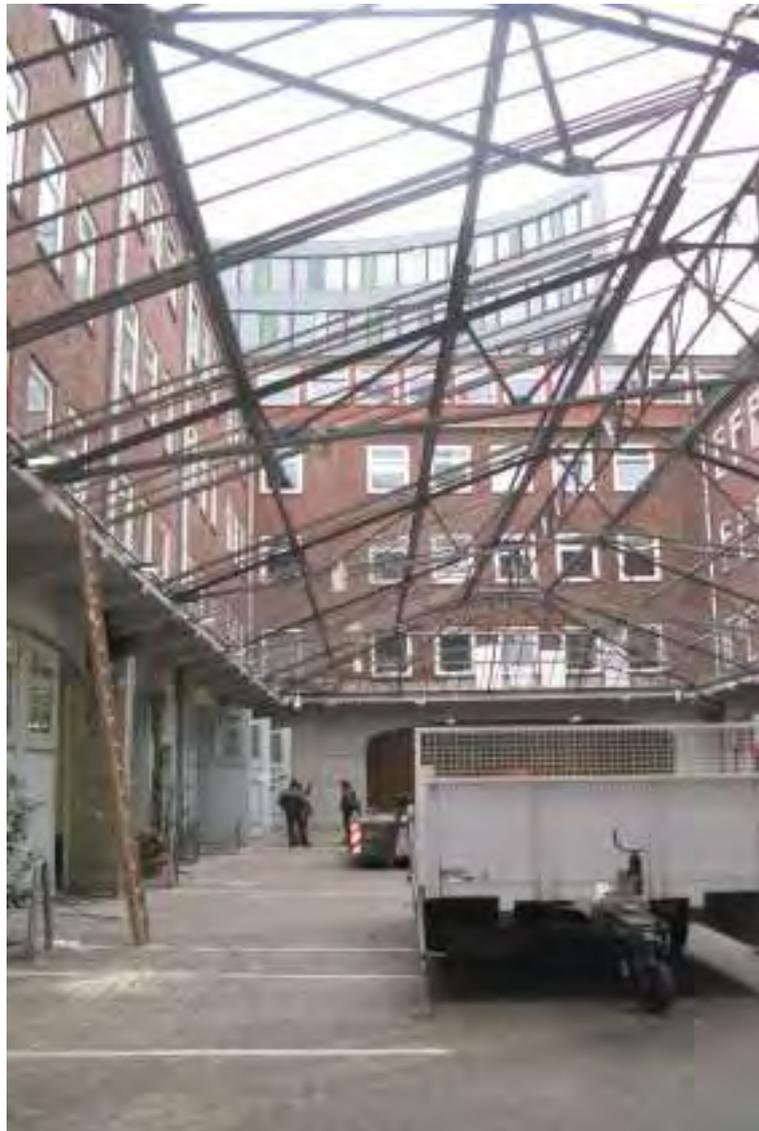
**Bild 12** Zustand des Dachtragwerkes während der Demontagearbeiten am 28.10.2008.
