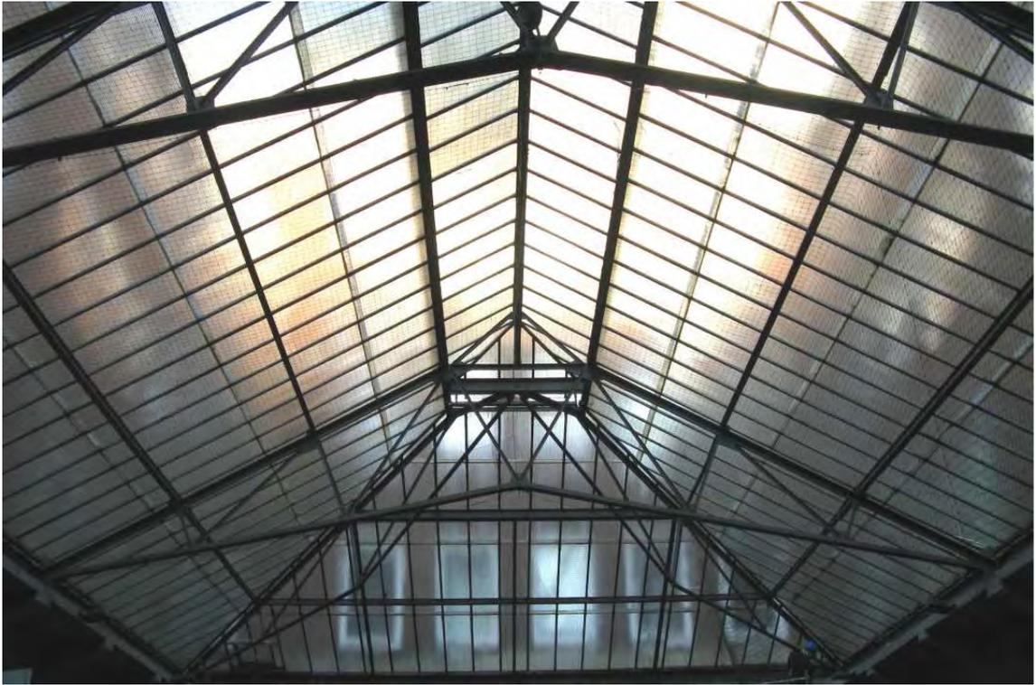
**Bild 7**      Drei Walmträger an der Stirnseite in nördlicher Ausrichtung.
