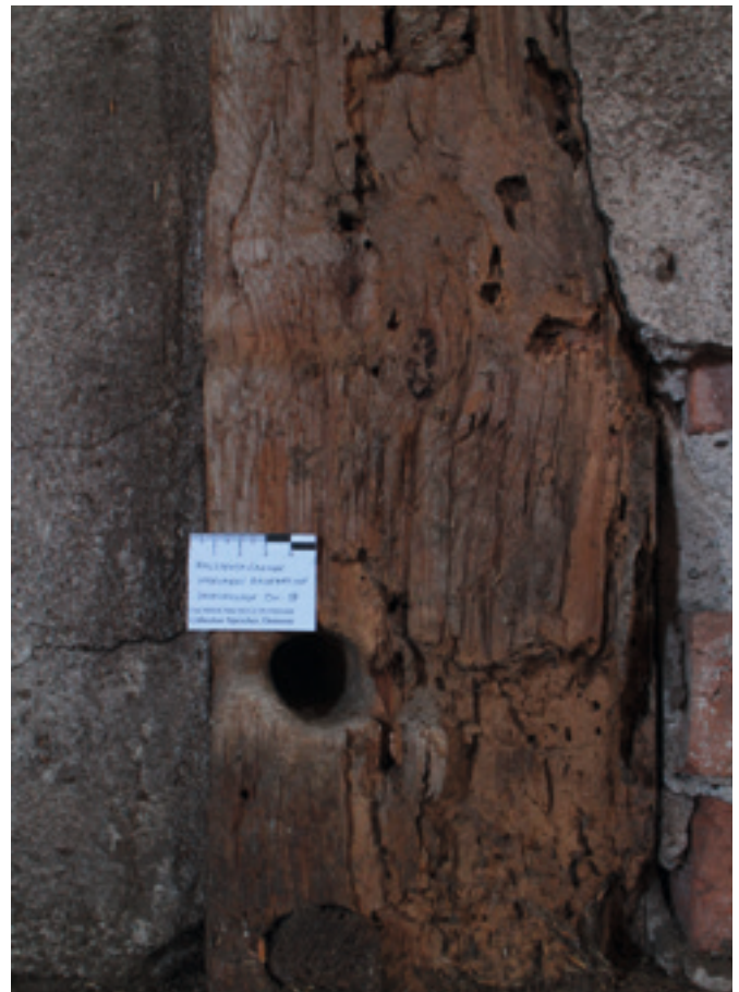
Abb.42 Holzerstörende Insekten (Ost17)
