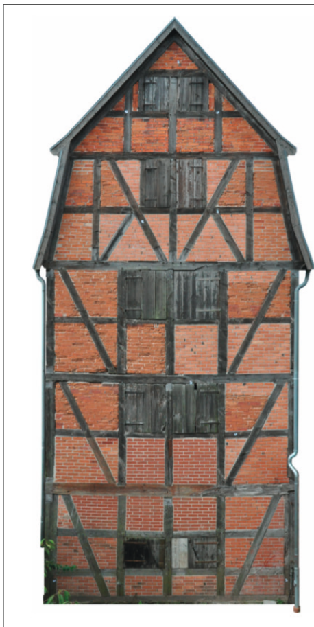
Abb.19 Ansicht von Norden
