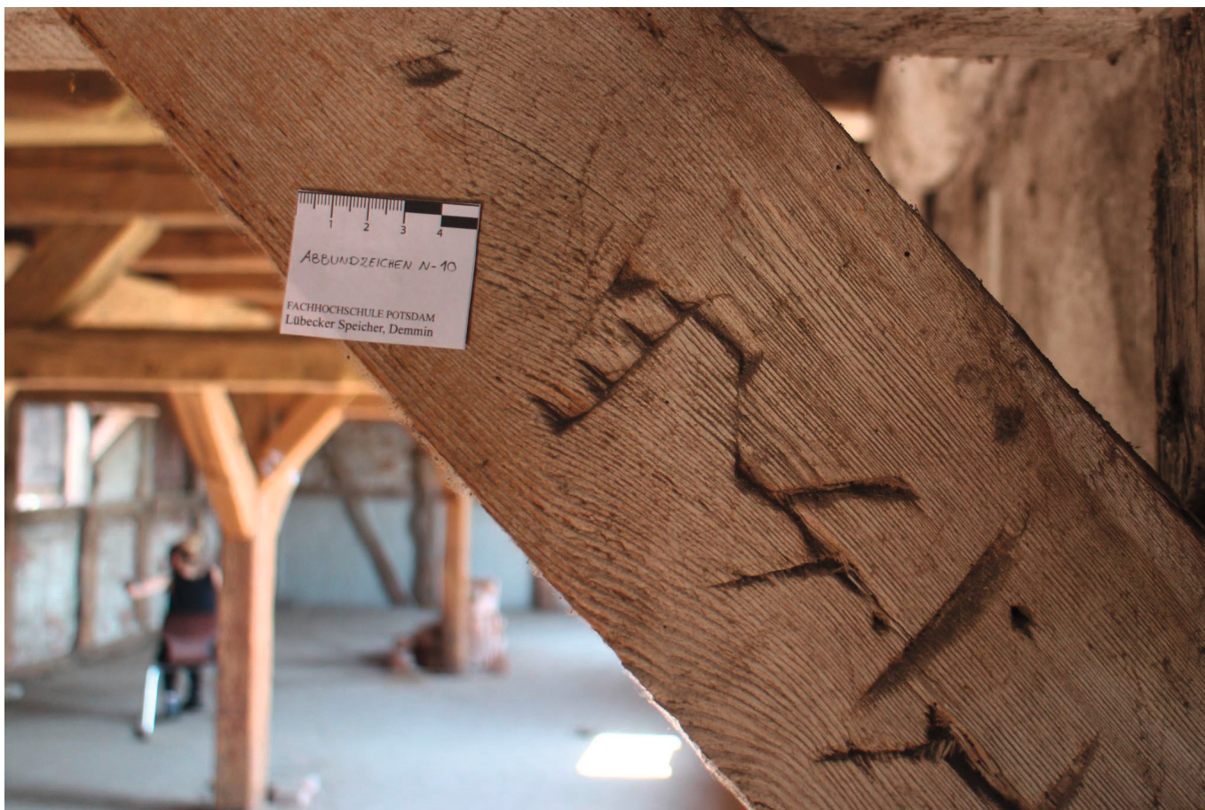
Abb.39 Abbundzeichen N16, 2. Obergeschoss
