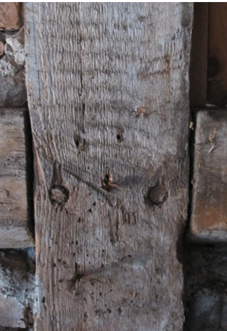
Abb.70 Verzapfung mit Holznägeln
