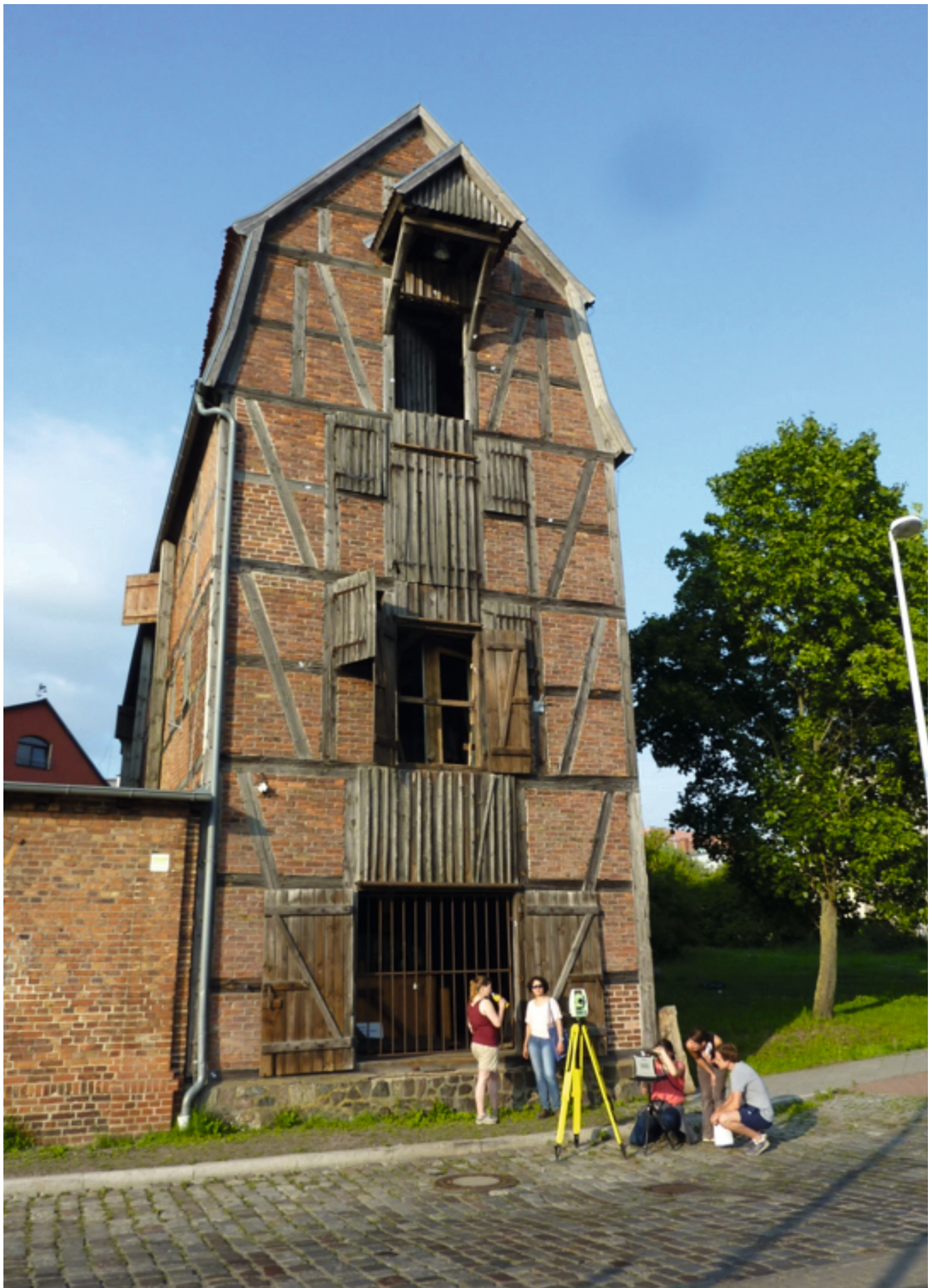
Abb.28 Arbeiten mit der Totalstation, Südfassade
