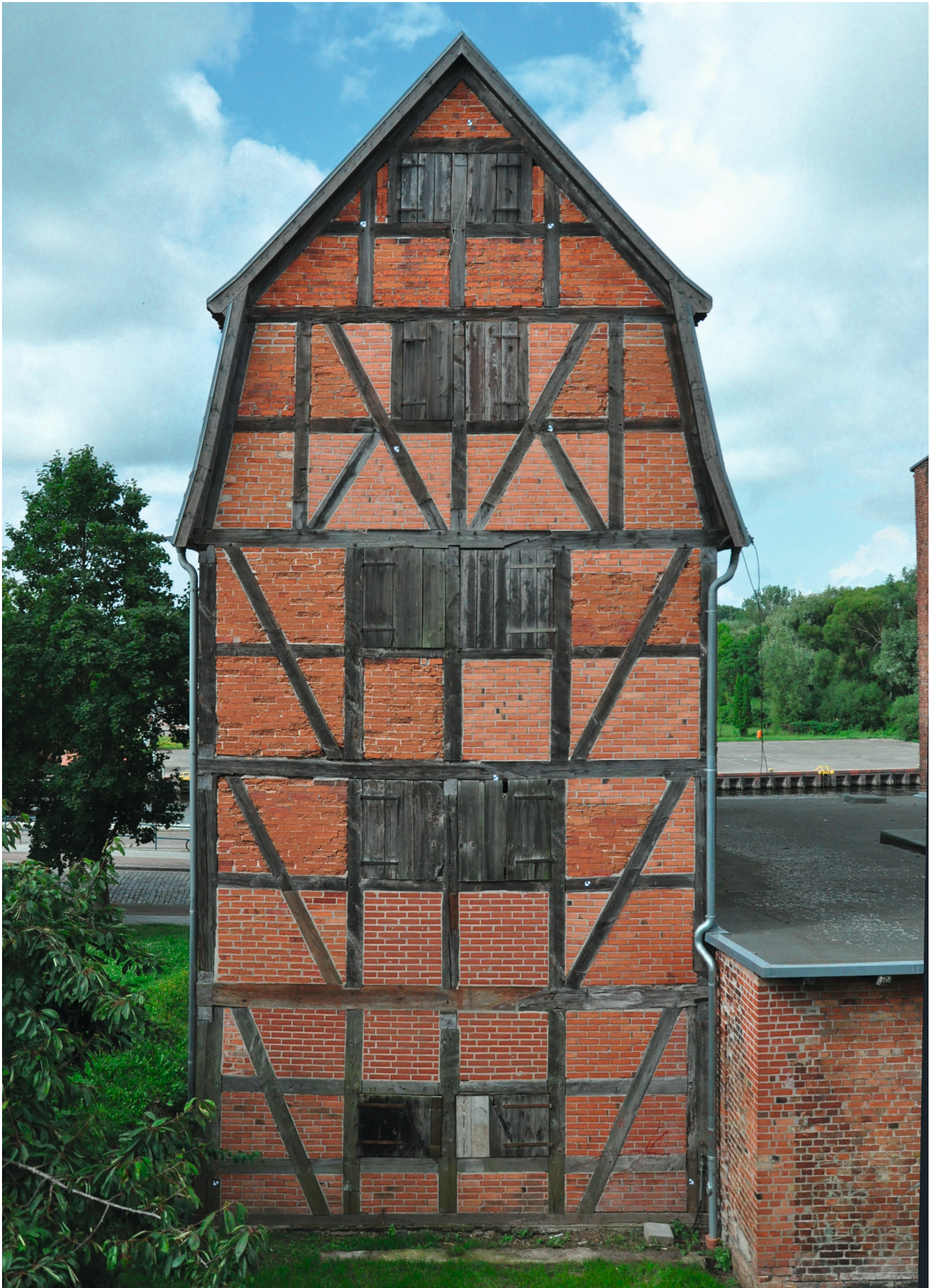
Abb.14 Ansicht Nordfassade, entzerzte Fotografie
