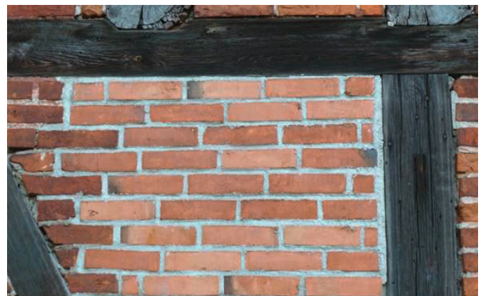
Abb.25 Fachwerk-Detail
