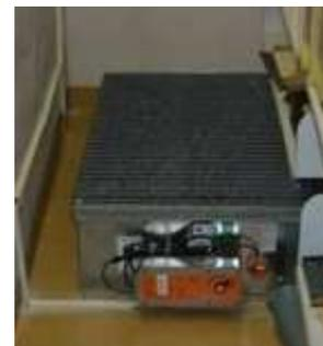
Abb. 3: Brandschutzklappe im Magazin
