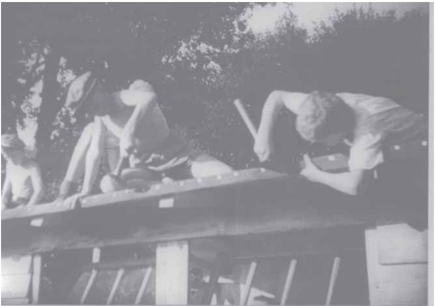
Abb. 6: Fortschritte des Rohbaus: das Landheim nimmt Gestalt an
