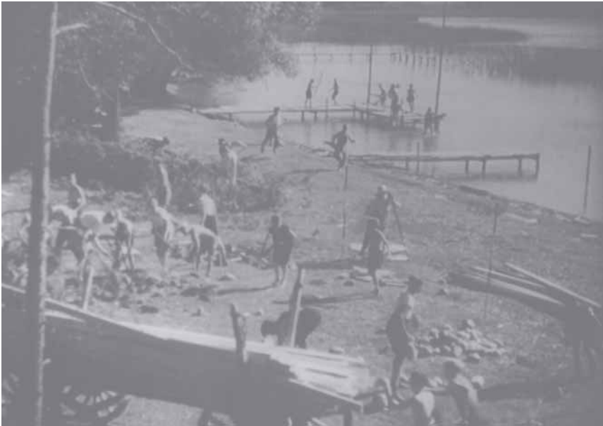
Abb. 5: Beginn der Bauarbeiten am „Breitlingsee“
