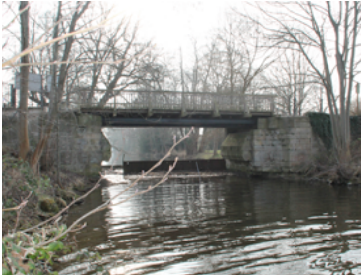
Abb. 42 Blick von der Oberstrom- seite. Fotos: Drexler, Schäpel 2015.
