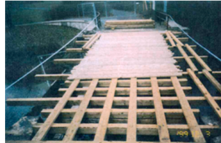
Abb. 38 Verlegung des Bohlen- belages.
