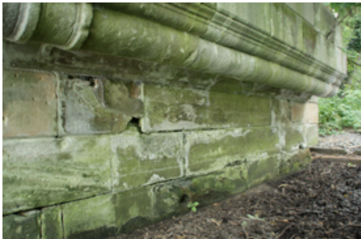
Abb. 14–16 14 Brückenpfeiler. Foto: Drexler, Schäpel 2015. 15, 16 Sandsteinvolute an der Kragkonsole. Foto: Drexler, Schäpel 2015.
