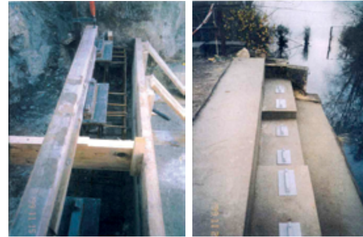
Abb. 36, 37 Herstellung der Auflagerbe- wehrung für Brücken- bzw. Trägeraufleger. Gegossene Betonaufleger.
