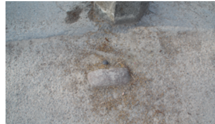
Abb. 17, 18 Ehemalige Torverankerungen mit sog. Stoppstein. Foto: Drexler, Schäpel 2015.
