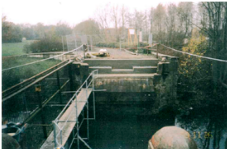
Abb. 35 Herstellung der Brückenaufleger.
