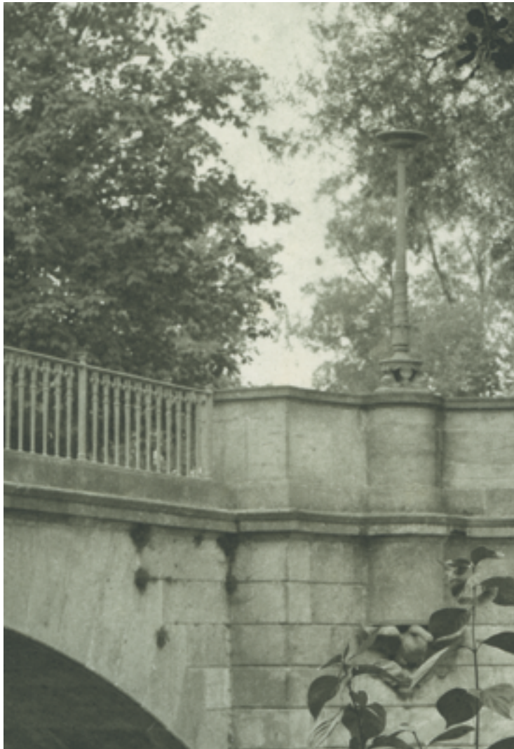
Abb. 20 Gesandelter Überzug am gusseisernen Kandelaber und Geländer (Ausschnitt/ Potsdam Museum). (Taf. XXVI)
