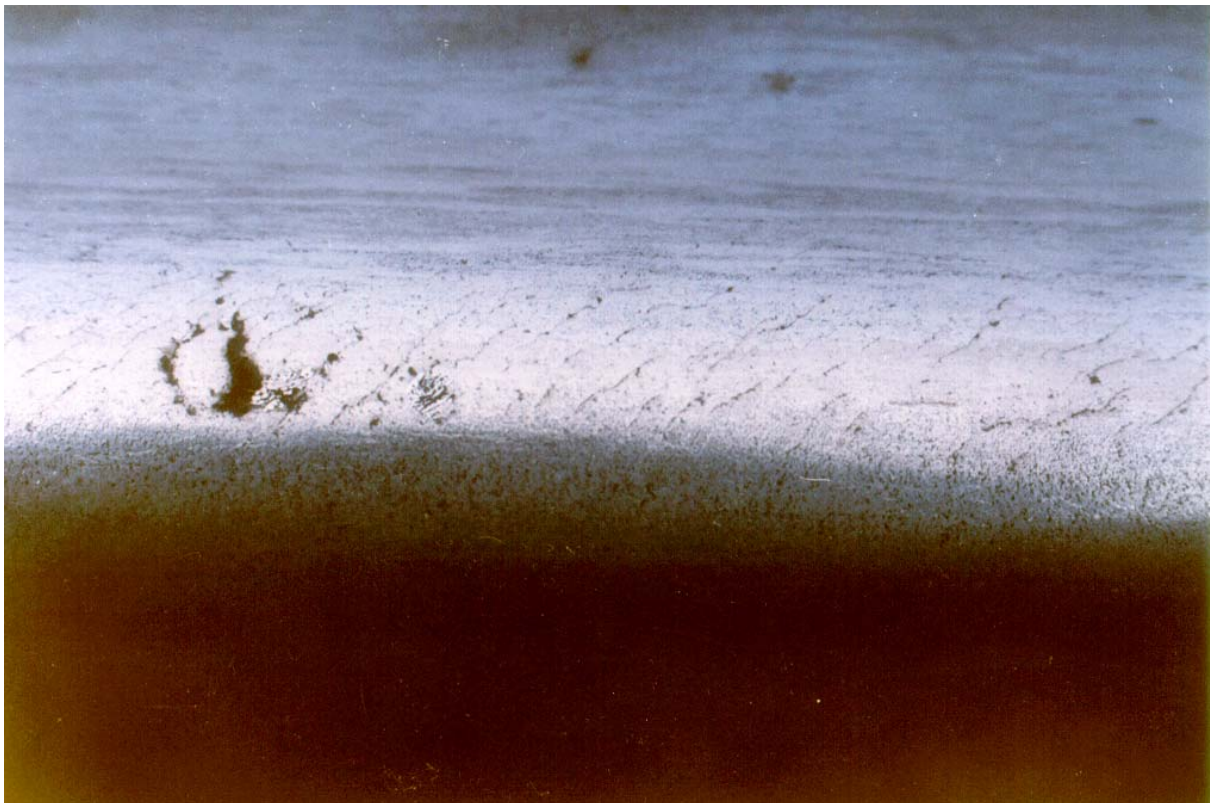
Bild 1: Head Checks im Außenbogen eines Gleises, Liegedauer 2 Jahre
