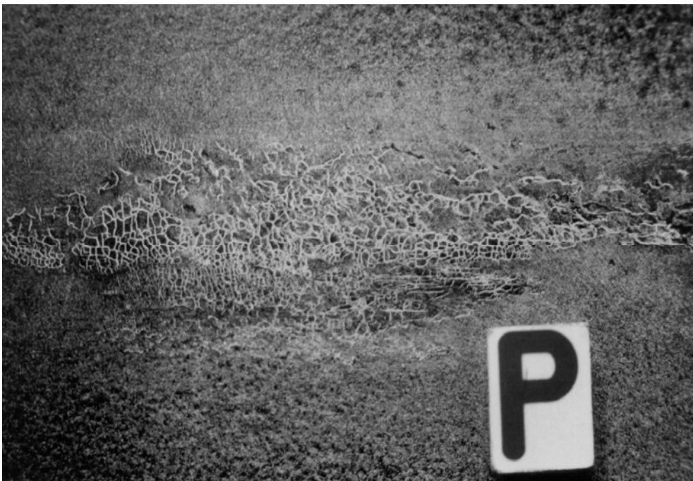
Bild 12: Rissnetz einer stark verriffelten Schiene – Magnetpulverprüfung mit UV-Licht.
