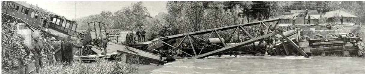
Bild 17: Die 1891 zerstörte Eisenbahnbrücke bei Münchenstein. [20]
